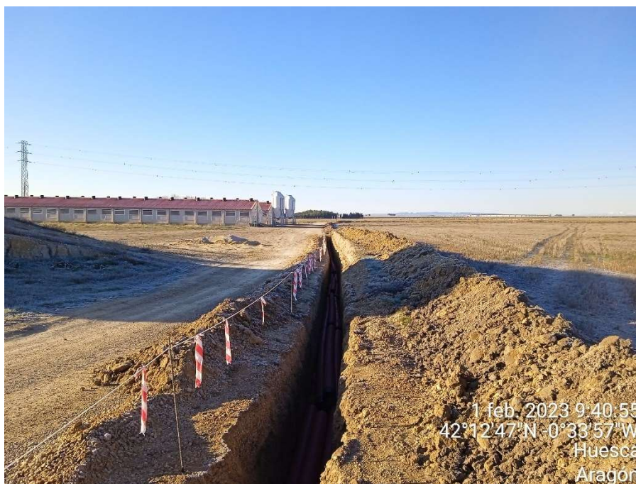
Imagen 2.- Tendido del tubo protector de la línea de evacuación.
