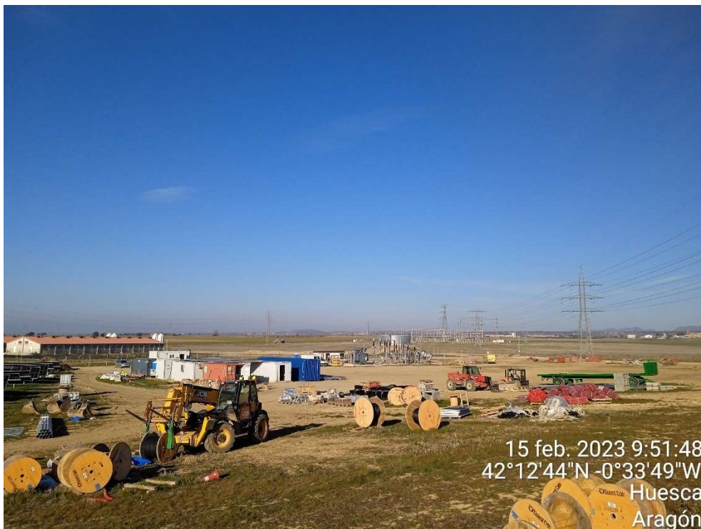
Imagen 10.- Zona de instalaciones auxiliares y S.E.T.
