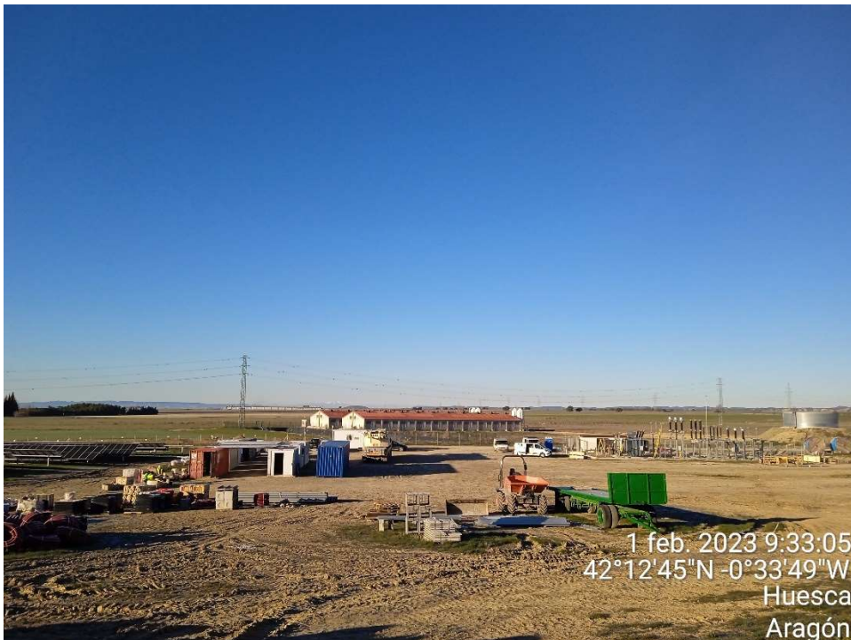
Imagen 10.- Zona de instalaciones auxiliares y S.E.T.
