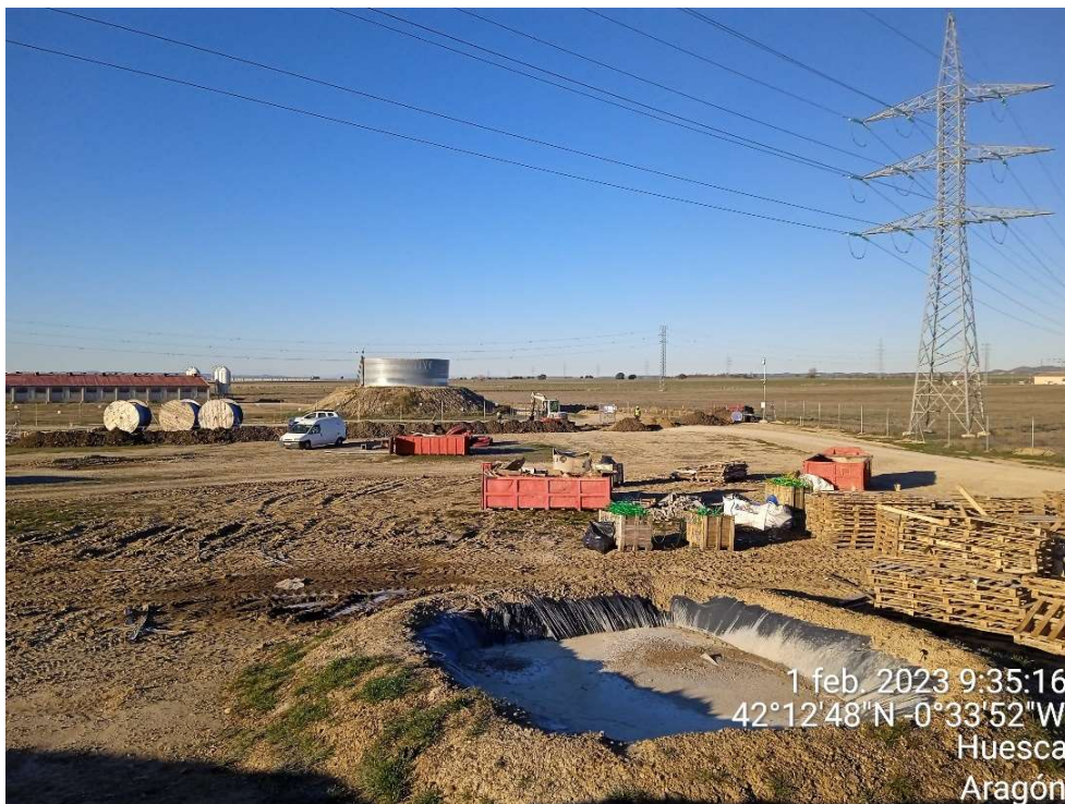
Imagen 12.- Punto limpio de Residuos no peligrosos.
