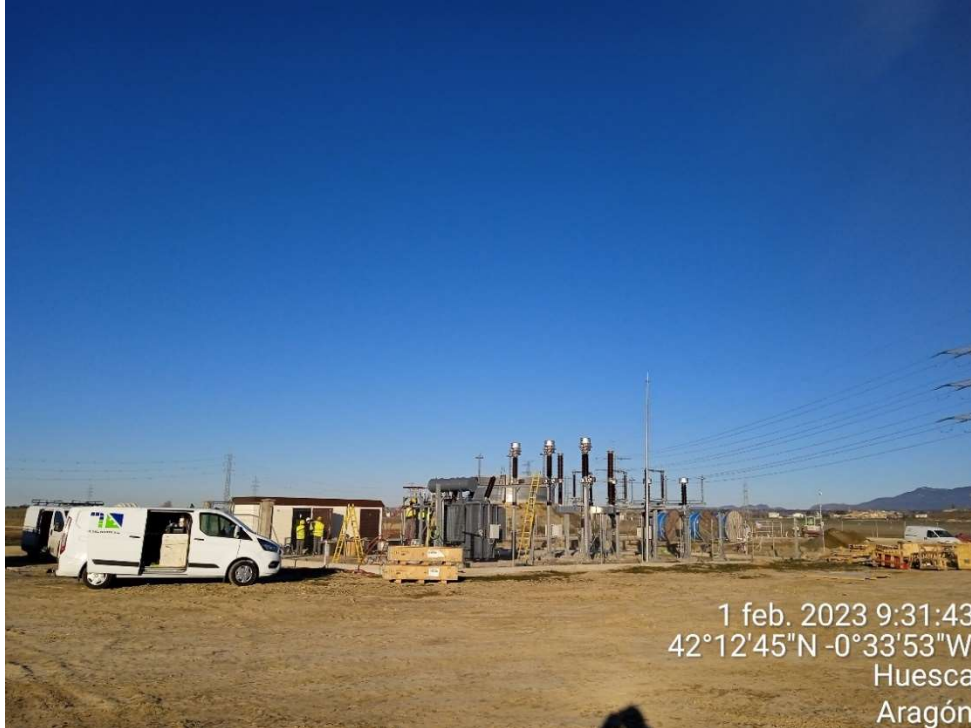
Imagen 11.- Trabajos en la Subestación de Transformación.
