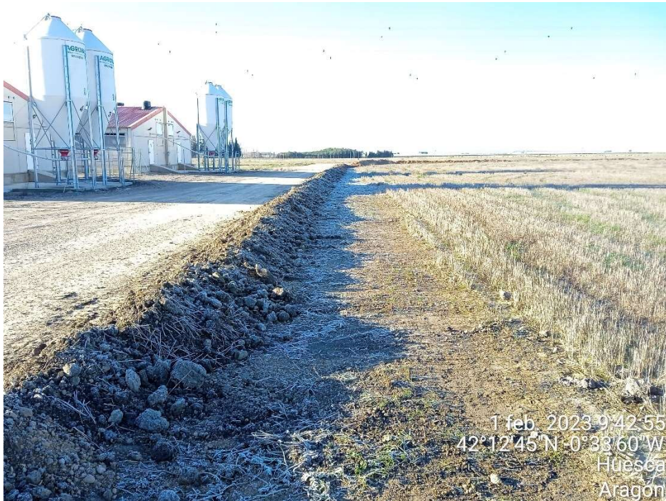
Imagen 3.- Primeros trabajos de tapado de la línea de evacuación
