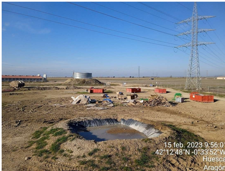
Imagen 12.- Punto limpio de Residuos no peligrosos.
