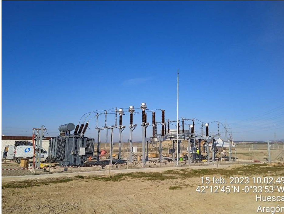
Imagen 11.- Trabajos en la Subestación de Transformación.
