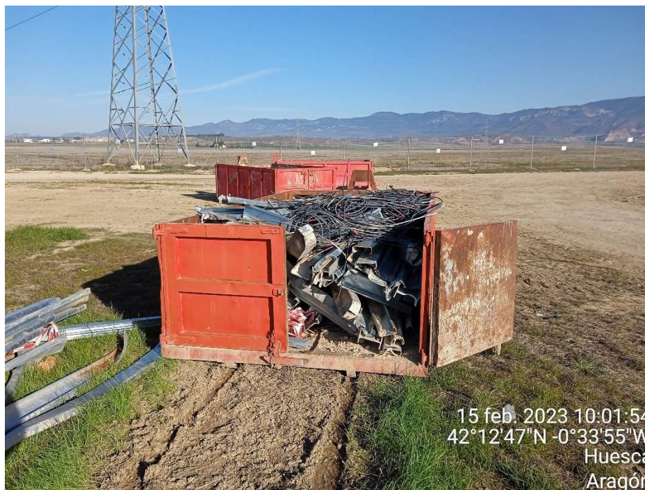
Imagen 14. Contenedor para metal del Punto limpio de Residuos no peligrosos.
