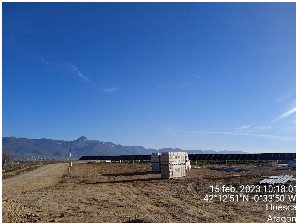
Imagen 8. Palets con los módulos fotovoltaicos esperando para ser instalados.
