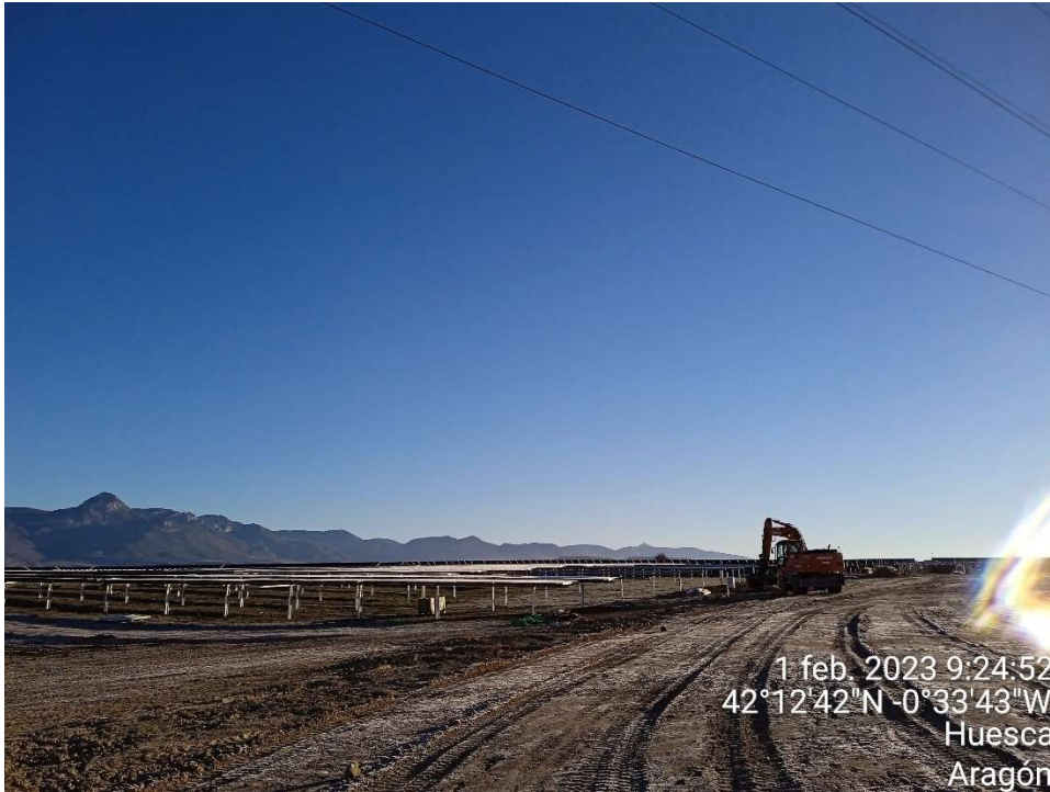
Imagen 5.- Máquina trabajando en las conducciones de baja tensión.
