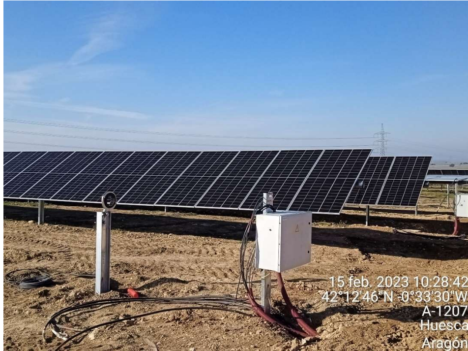
Imagen 5.- Trabajos de conexión a las conducciones de baja tensión.
