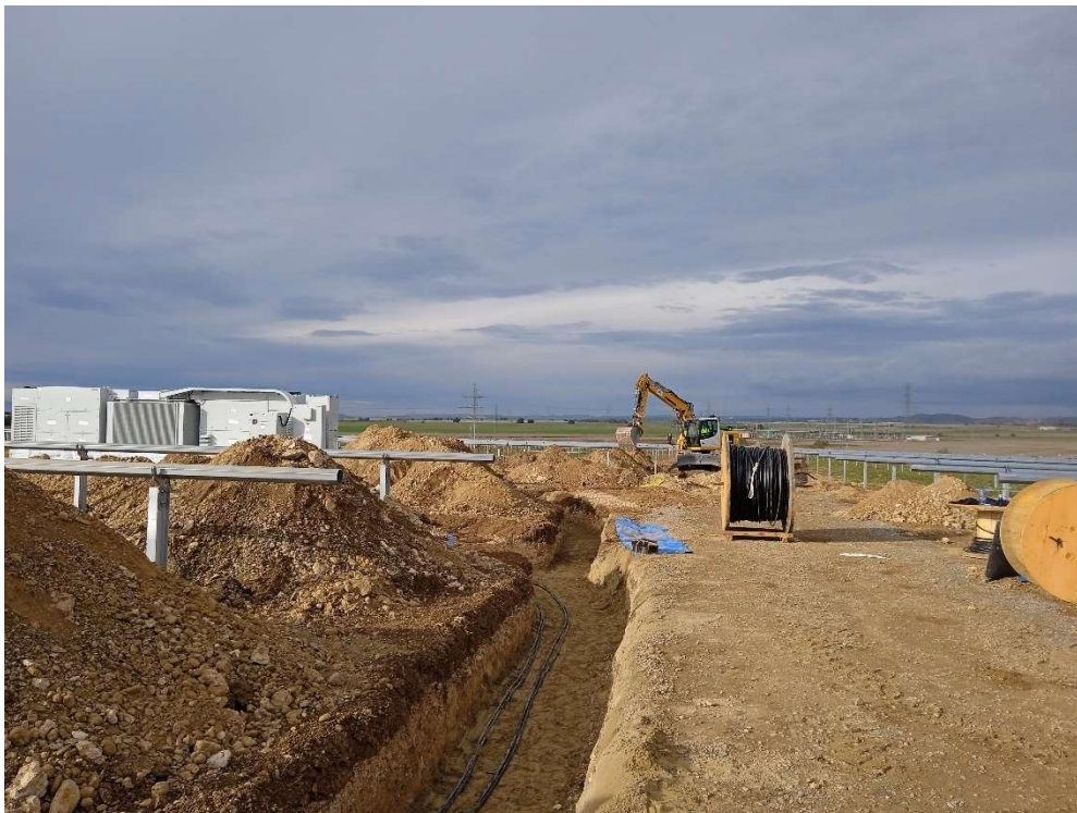
Imagen 8. Trabajos en las conducciones de baja tensión.
