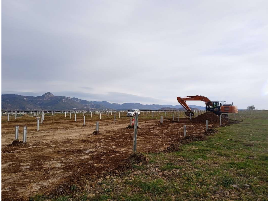
Imagen 1. Una de las zonas de la planta solar en la que se está rebajando el terreno para el buen funcionamiento de los seguidores.
