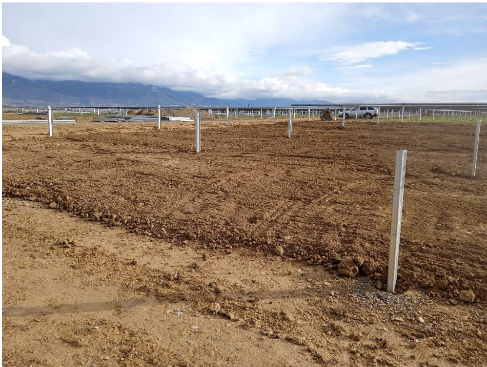
Imagen 4. Montaje de los seguidores de los módulos fotovoltaicos.
