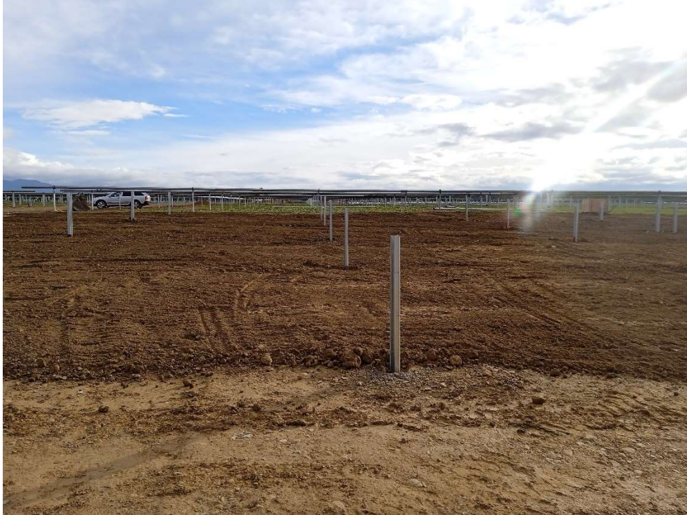
Imagen 3. Capa de tierra vegetal extendida sobre una zona rebajada.
