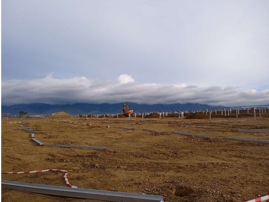
Imagen 1. Máquina trabajando en el extendido de tierra vegetal y postes de los seguidores preparados para su hincado.
