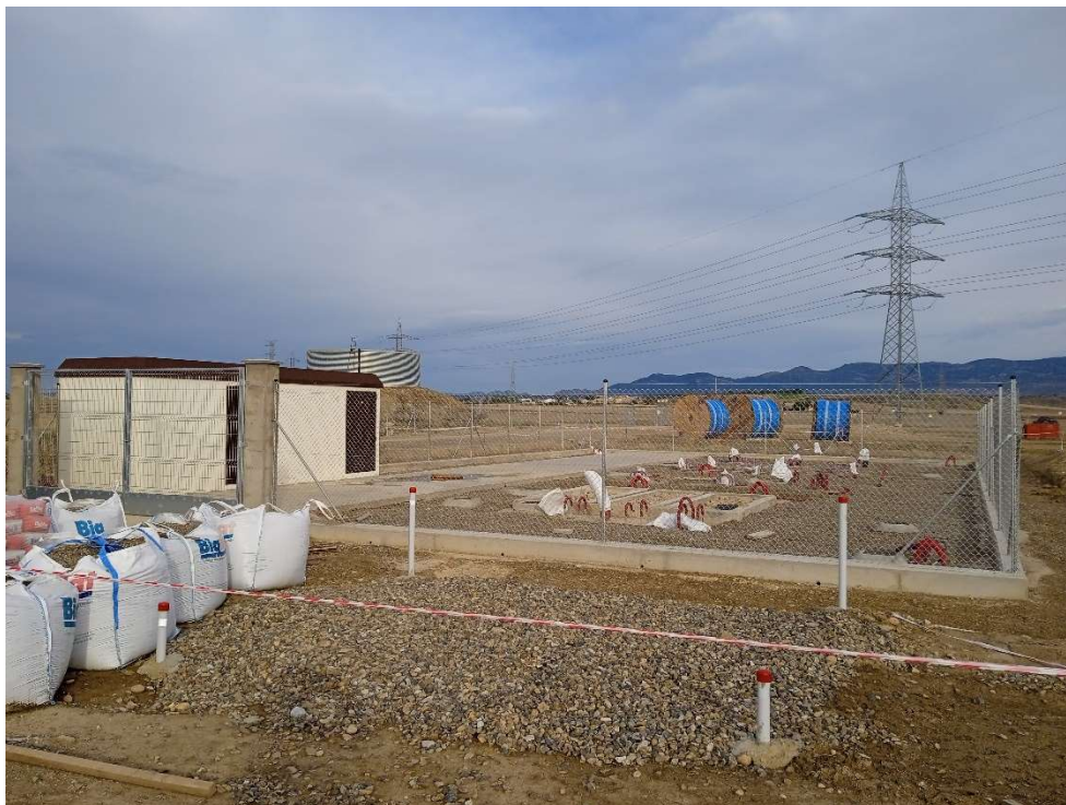
Imagen 8.- Trabajos en la Subestación de Transformación.
