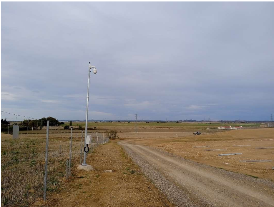
Imagen 2. Sistema de seguridad de la planta solar.
