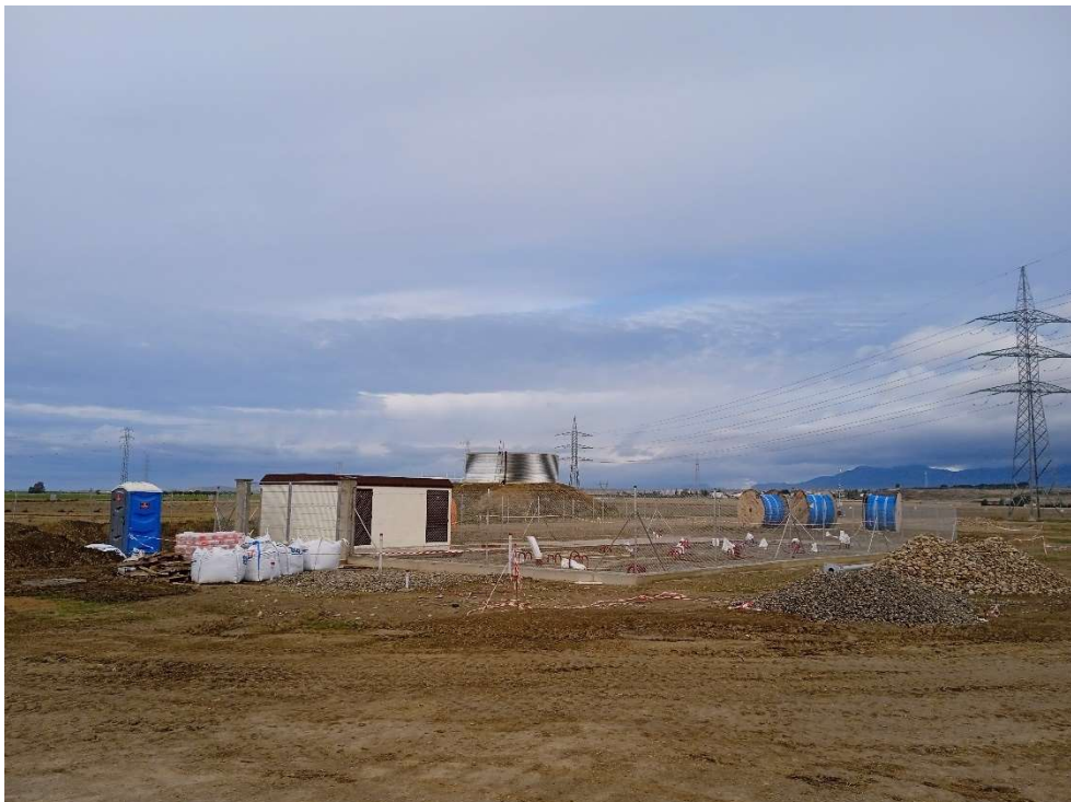
Imagen 10.- Trabajos en la Subestación de Transformación.
