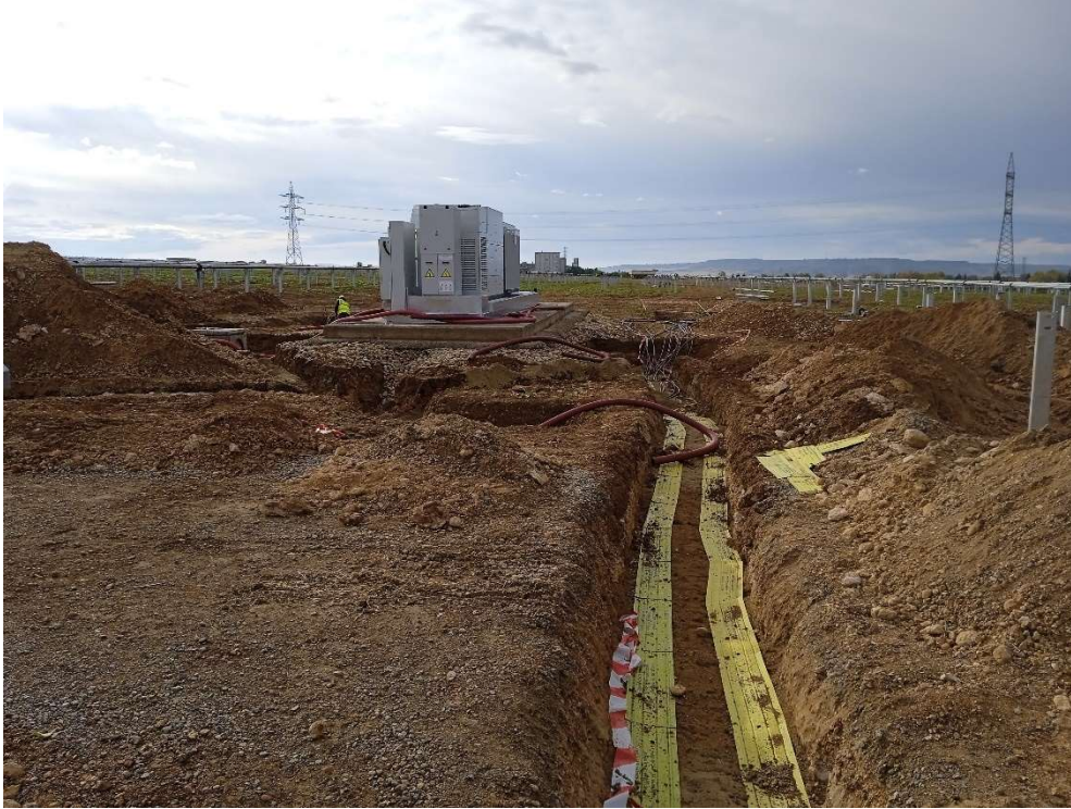
Imagen 7. Trabajos en las conducciones de baja tensión.
