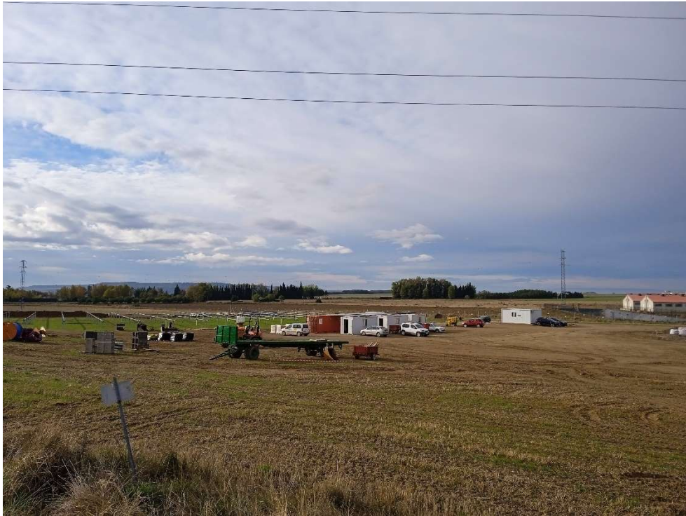
Imagen 9.- Vista general de la zona de Instalaciones auxiliares.
