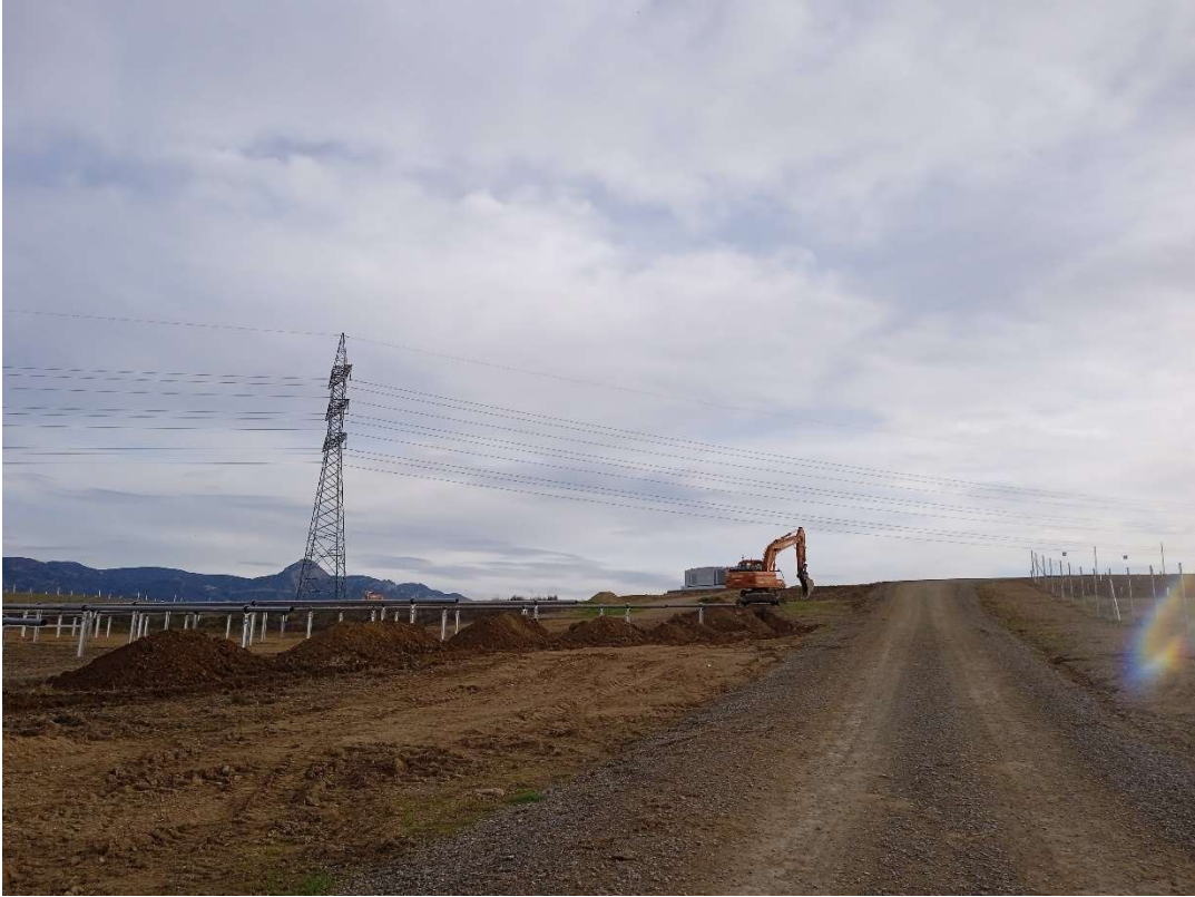
Imagen 5. Trabajos en las conducciones de baja tensión.
