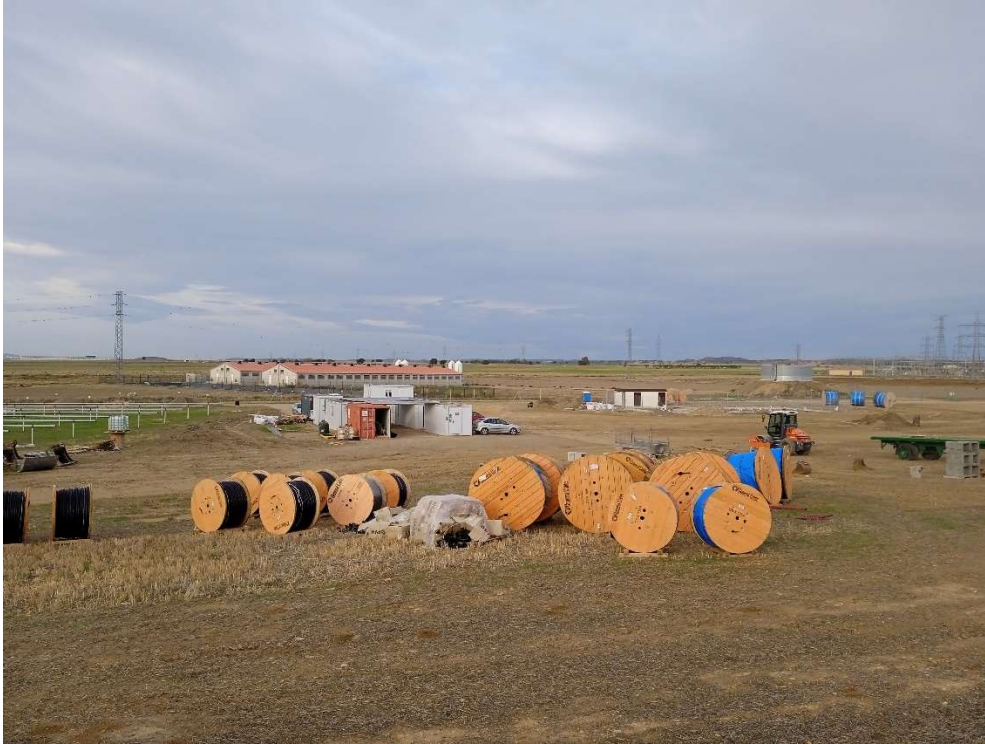
Imagen 7.- Vista general de la zona de Instalaciones auxiliares.
