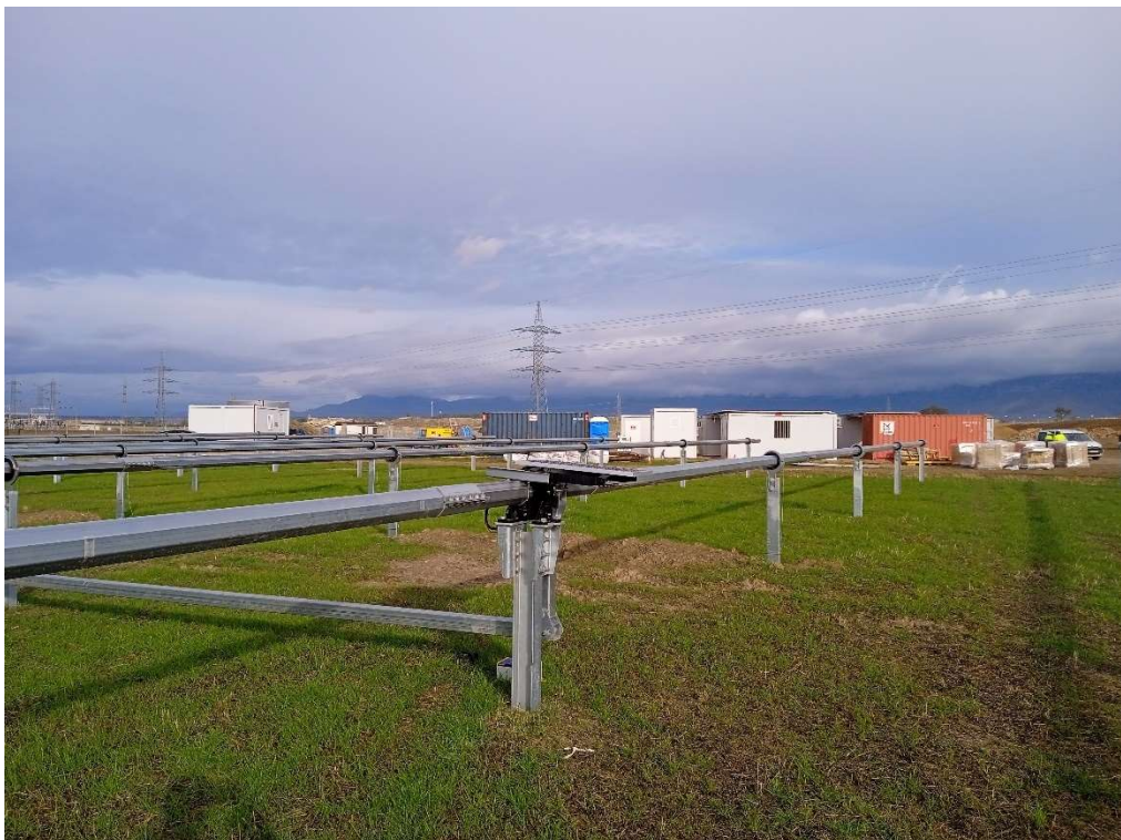
Imagen 6. Montaje de los seguidores de los módulos fotovoltaicos.
