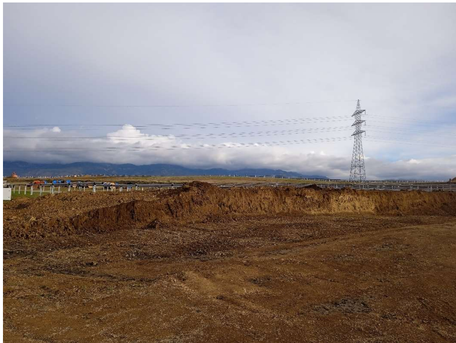
Imagen 2. Cordón de tierra vegetal acopiada.
