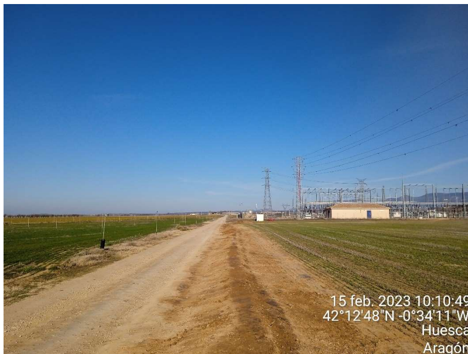
Imagen 22.- Camino y campo de cultivo restituidos a su estado original tras la instalación de la línea de evacuación.
