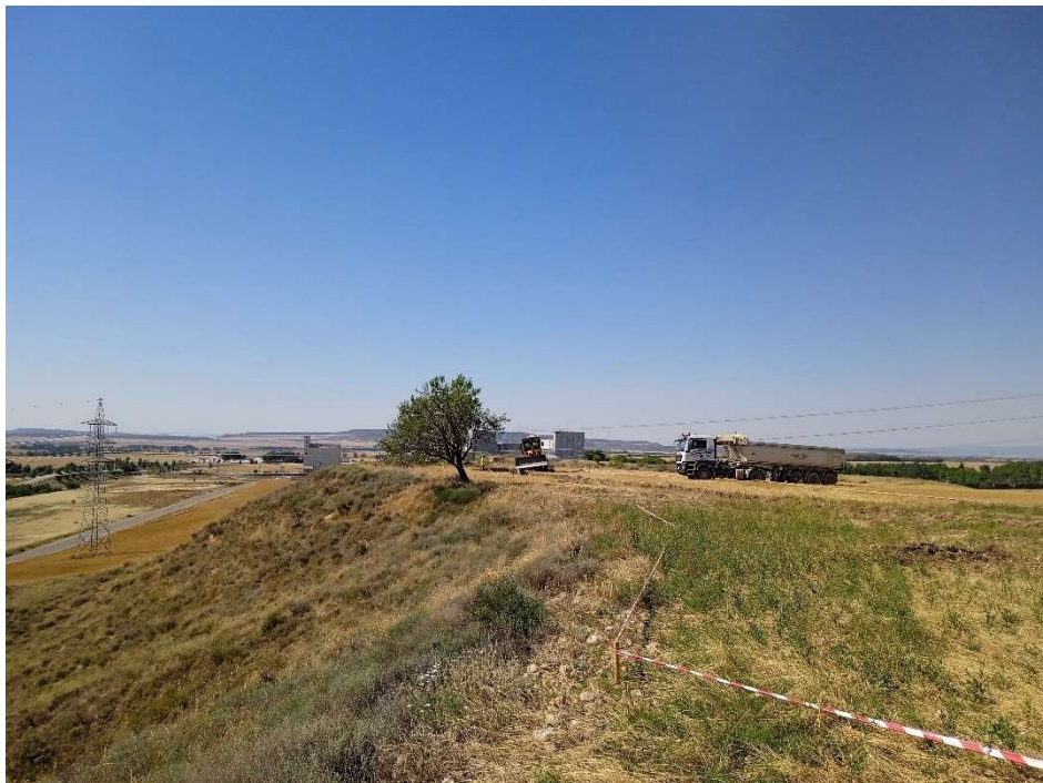
Imagen 2.- Jalonado previo a las obras del Hábitat de Interés Comunitario prioritario situado en las laderas al este de la planta solar.
