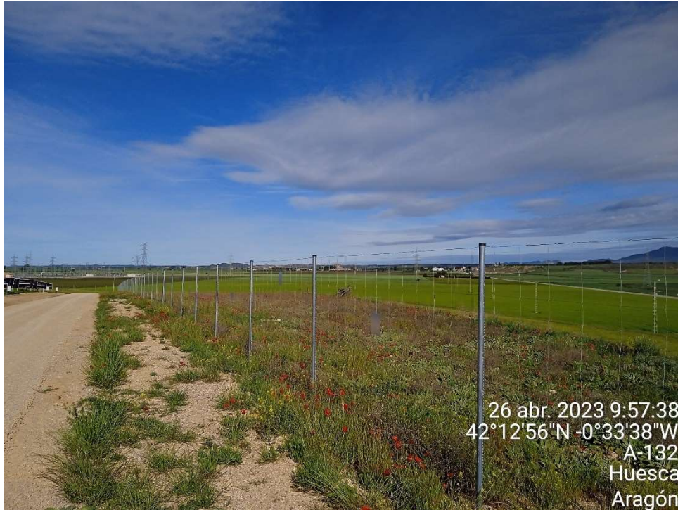
Imagen 11.- Vallado perimetral construido siguiendo la Resolución del INAGA. Se aprecia el regenerado natural de la vegetación en el lateral del vial.
