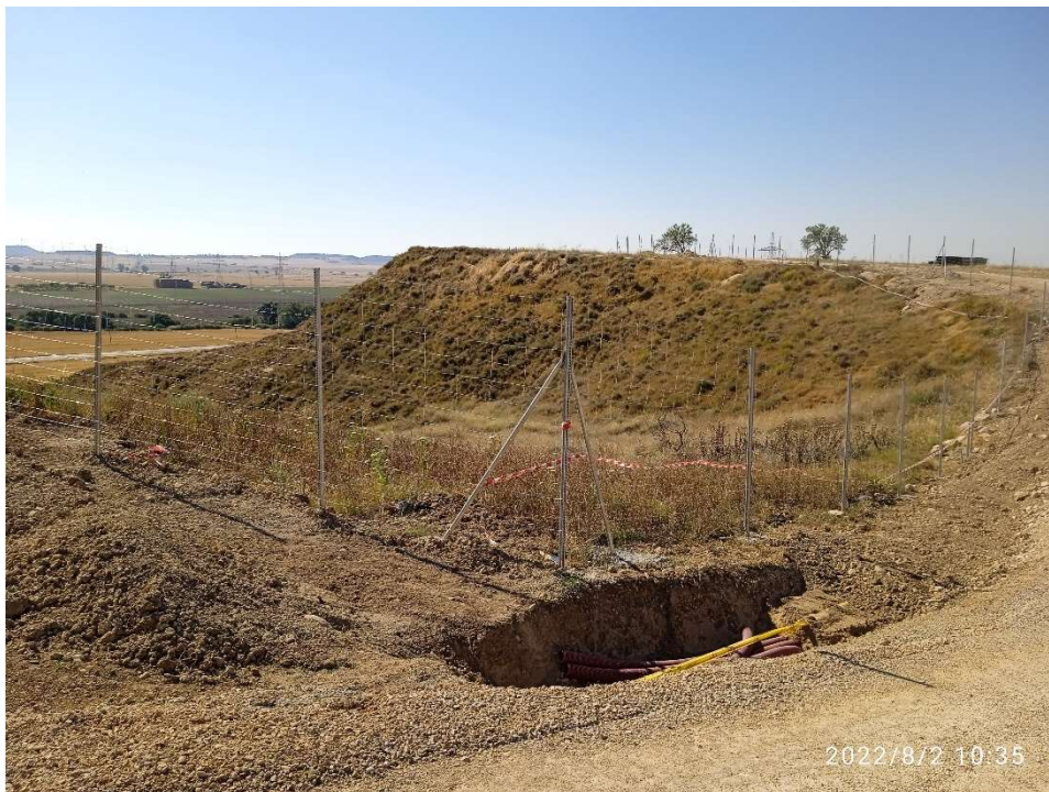
Imagen 10.- Ladera con el Hábitat prioritario 6220 protegida por el vallado perimetral de la planta.
