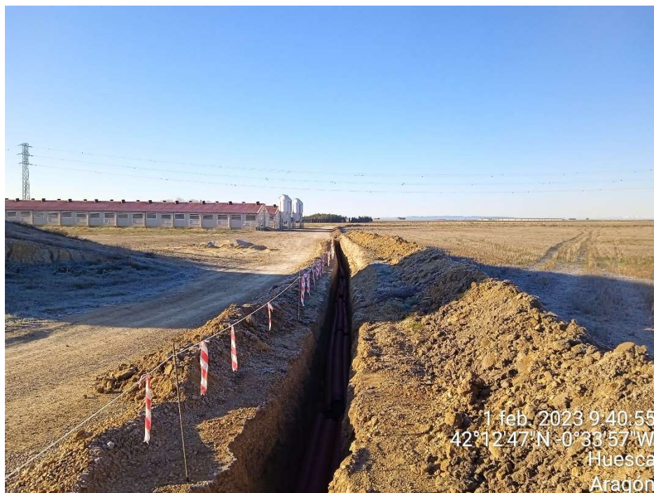
Imagen 21.- Trabajos de construcción de la línea de evacuación, por el lateral del camino principal de acceso a la planta solar.
