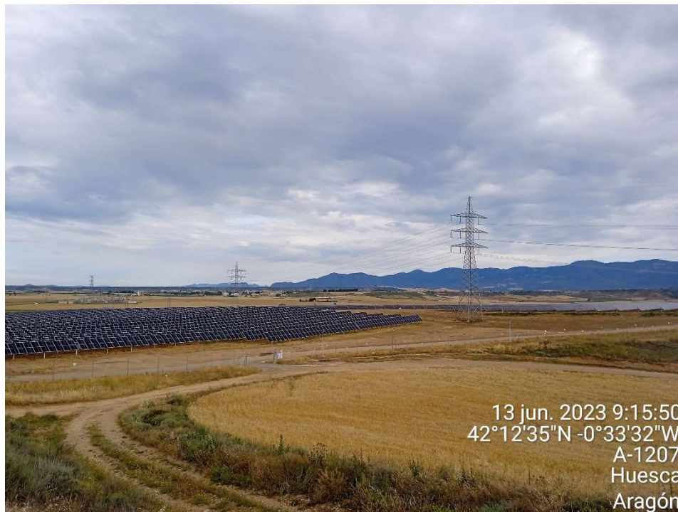
Imagen 5.- Vista general de la planta solar desde el acceso por el este.
