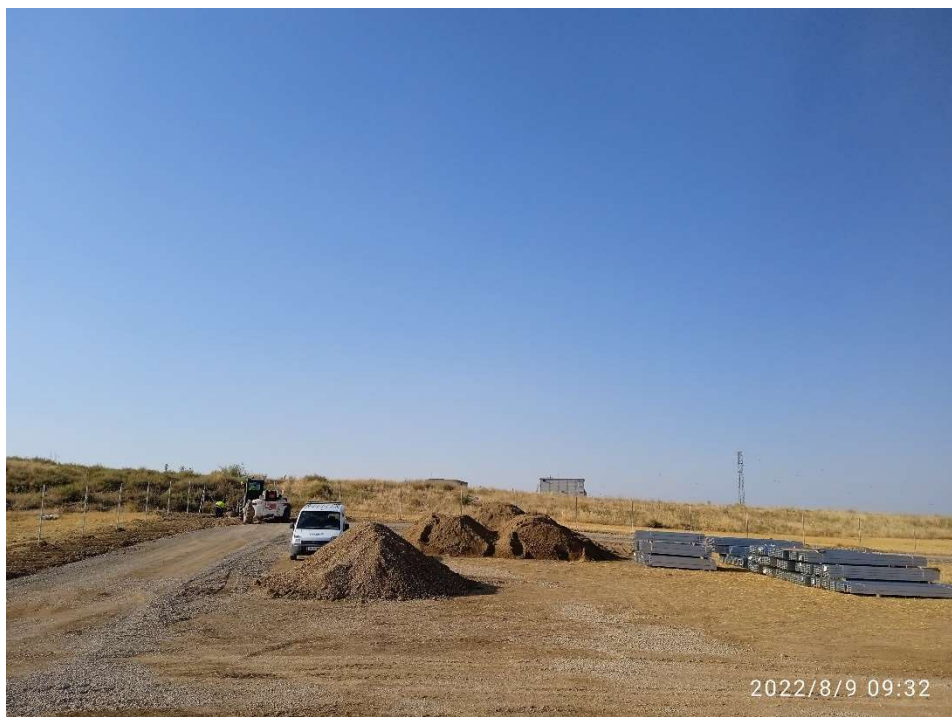
Imagen 6.-Una de las zonas de acopio de tierra vegetal y material.
