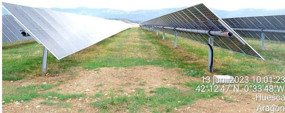
Imagen 9.- Situación tras el desbroce mecánico bajo ciertos seguidores.
