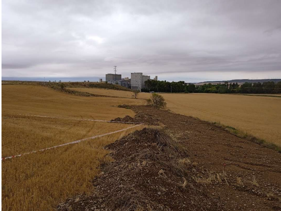
Imagen 7.-Trabajos de suavizado de un pequeño talud.
