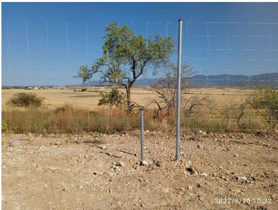
Imagen 12.- Detalle del vallado mostrando luz, espacio desde el suelo y paso de fauna.
