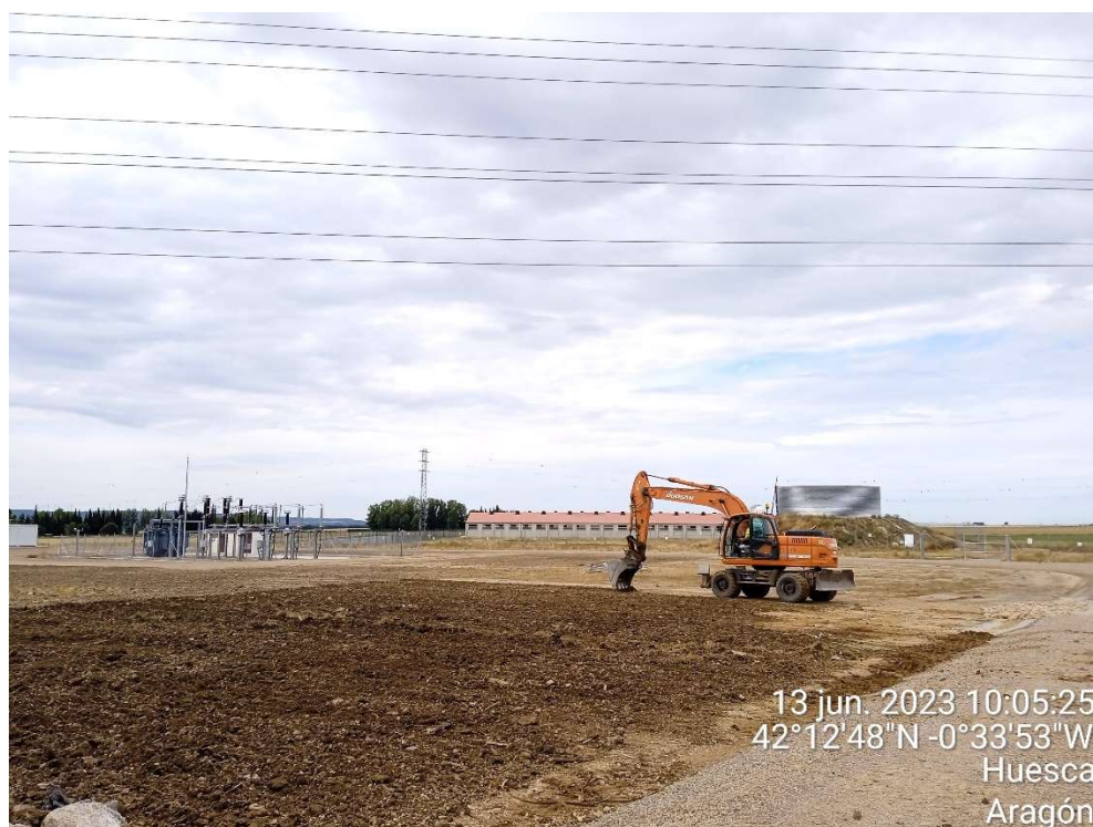
Imagen 24.- Trabajos de descompactado del terreno en la zona donde se ubicaba el Punto limpio de RnP.
