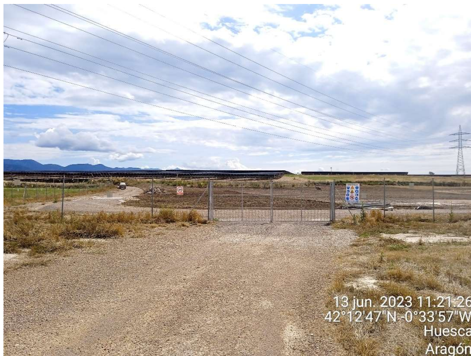
Imagen 4.- Vista del acceso principal de la planta solar, por la zona oeste.
