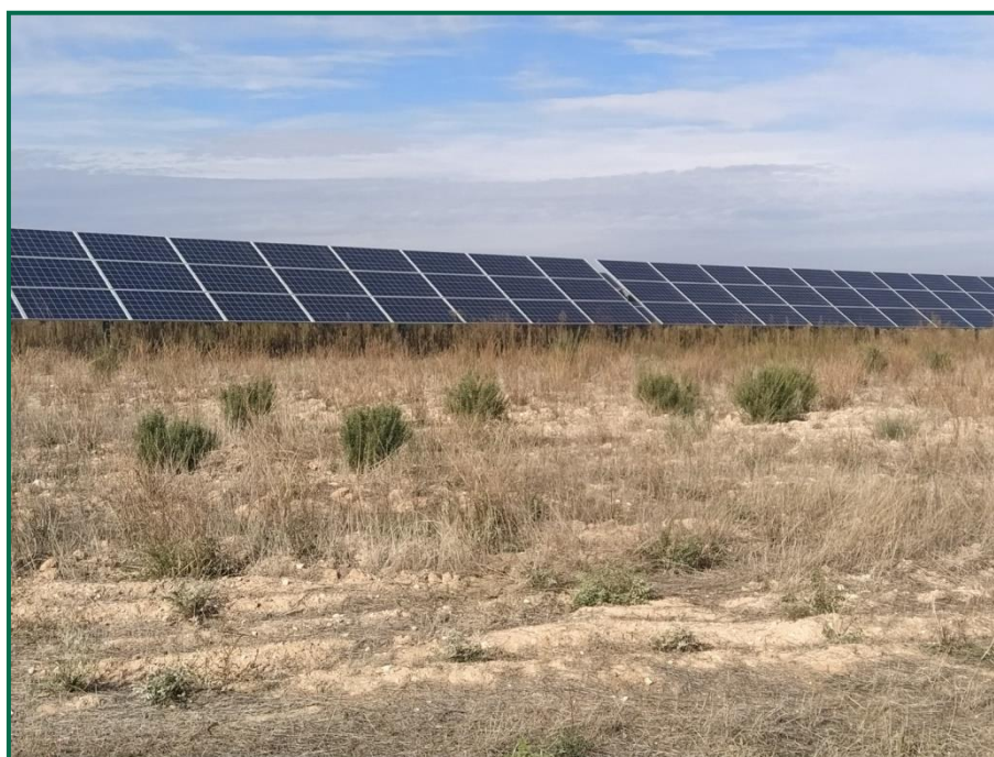
Fotografía 2. Zona revegetada en su estado actual.
