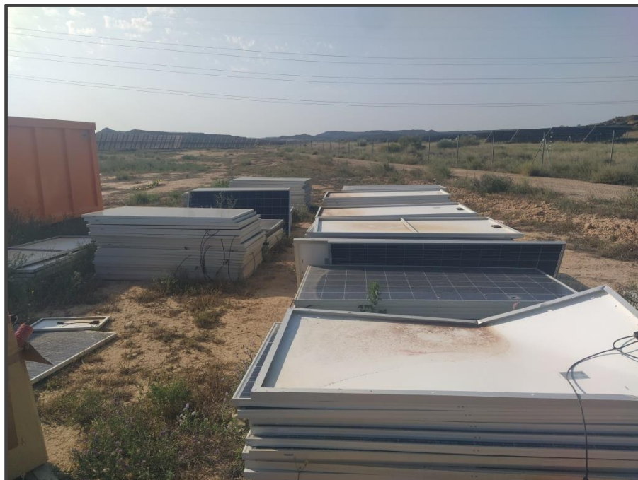
Fotografía 13. Zona de acopio de placas solares deterioradas.
