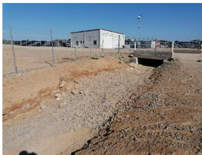
Fotografía 04.- Procesos erosivos. Cuneta reparada.
