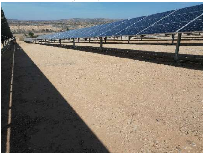
Fotografía 53.- Estado del suelo en bloques de construcción reciente. Cubierto vegetal rala y escasa. Febrero 2022.
