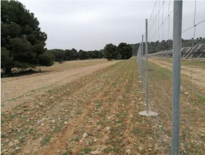
Fotografía 19.- Estado de las plantaciones perimetrales (semi-vallado Este, lado Norte). Marzo 2022.
