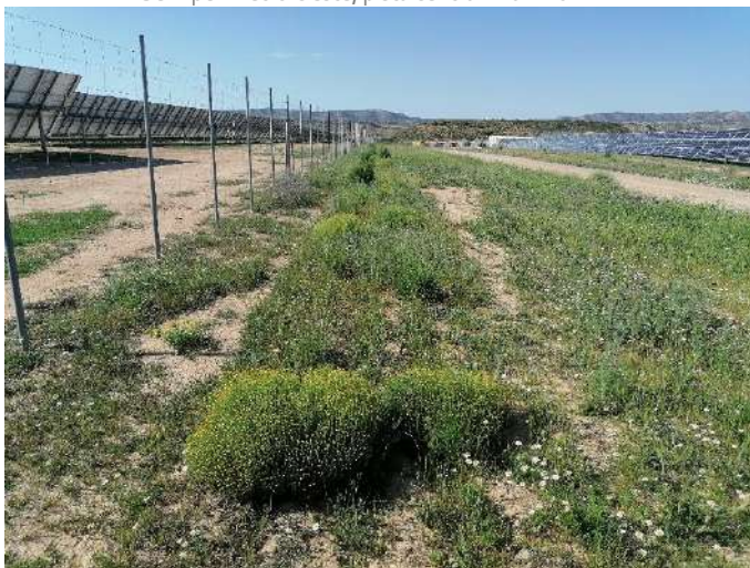
Fotografía 41.- Plantación perimetral de retama, romero y otras especies. Semiperímetro Oeste, pista central. Abril 2022.
