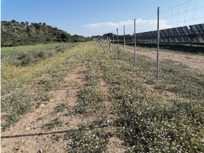
Fotografía 25.- Estado de la plantación perimetral de tamariz (semi-perímetro Este, extremo Norte, junto a GR). Abril 2022.
