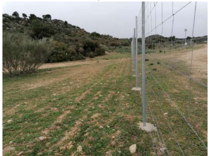
Fotografía 18.- Estado de las plantaciones perimetrales (semi-vallado Este, lado Norte). Marzo 2022.
