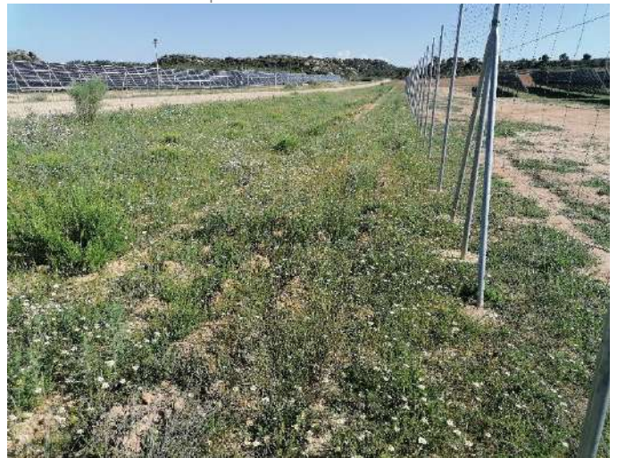
Fotografía 40.- Plantación perimetral de retama, romero y otras especies. Semiperímetro Oeste, pista central. Abril 2022.
