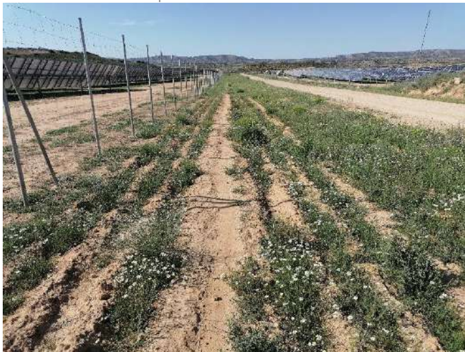
Fotografía 39.- Plantación perimetral de retama, romero y otras especies. Semiperímetro Oeste, pista central. Abril 2022.
