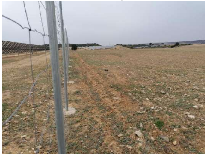
Fotografía 16.- Estado de las plantaciones perimetrales (semi-vallado Este, lado Norte). Marzo 2022.
