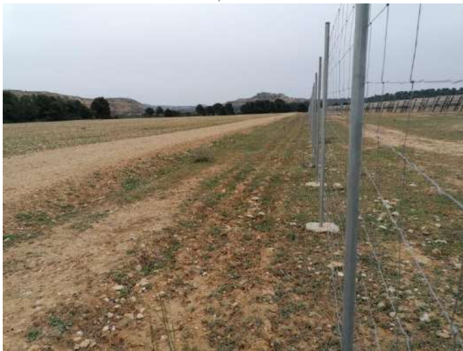
Fotografía 17.- Estado de las plantaciones perimetrales (semi-vallado Este, lado Norte). Marzo 2022.
