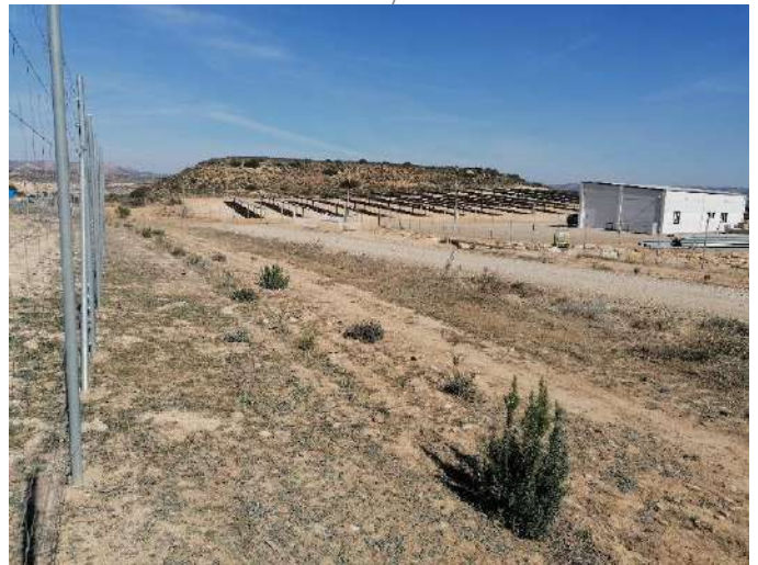
Fotografía 10. - Estado de las plantaciones perimetrales (semi-vallado Oeste, pista central). Febrero 2022.
