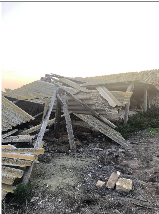
Foto del cubierto hundido que permite el acceso a los tejados de la paridera
