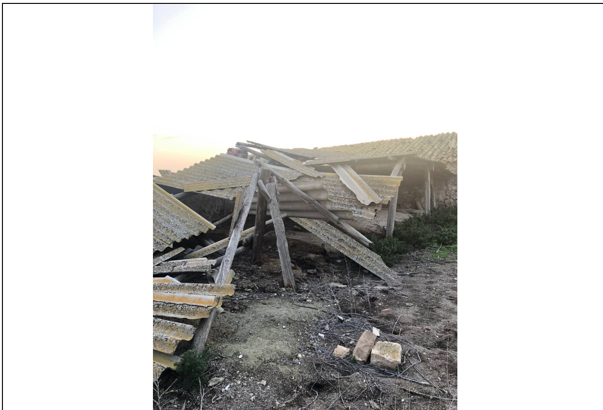
Gráfico 19º.- Foto del cubierto hundido que permite el acceso a los tejados de la paridera
