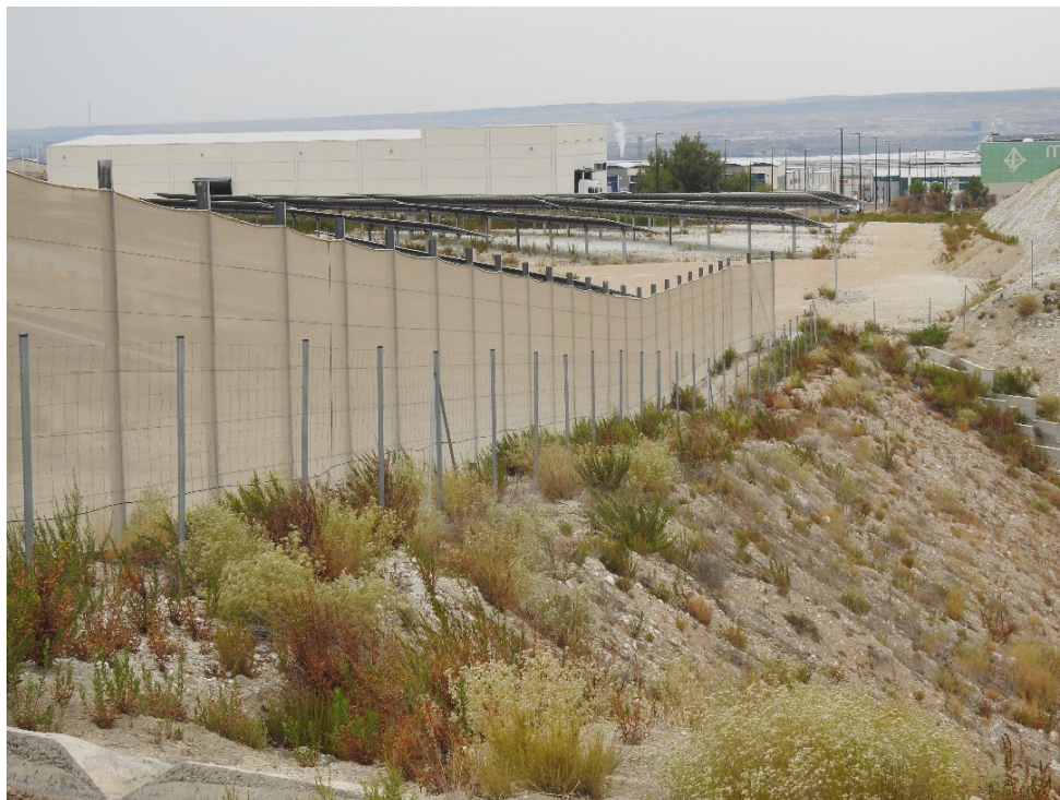
Fotografía 1: Crecimiento de la vegetación en los taludes y vallado perimetral
