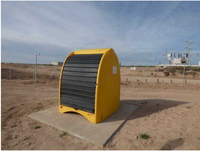
Imágenes 14 y 15: Imágenes del punto limpio que contiene los depósitos homologados para el almacenamiento de los residuos peligrosos (imágenes izquierda y derecha respectivamente)
