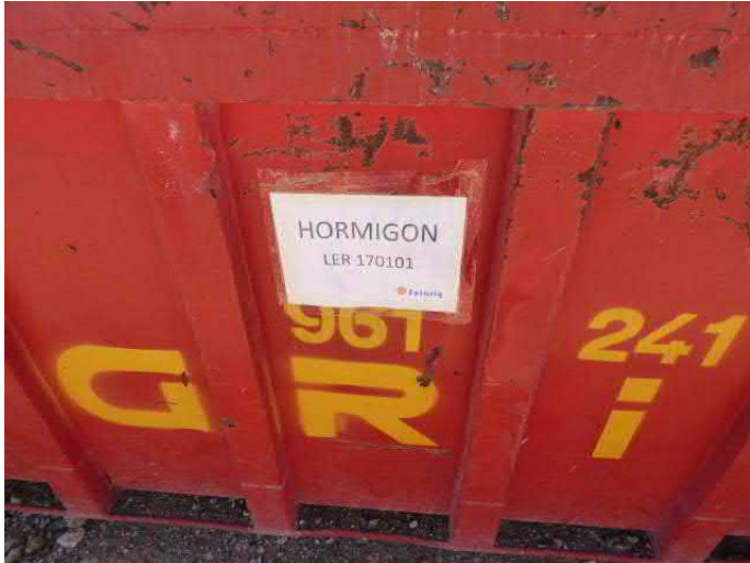
Imágenes 17 y 18: Etiquetado del contenedor del residuo no peligroso "hormigón" (fotos del lado izquierdo). Residuos en el interior del contenedor (fotos del lado derecho).
