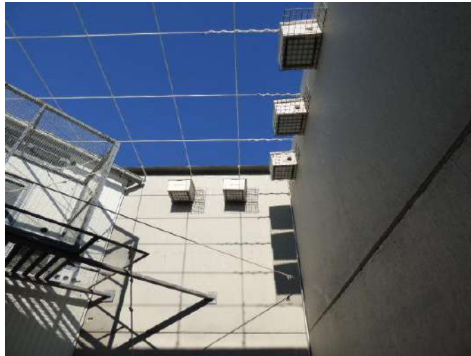
Imágenes 7, 8 y 9: Interior del primillar.
