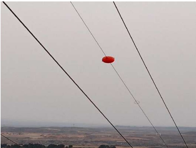
Imágenes 3 y 4: Estado de conservación de baliza esférica (Izquierda), y aisladores (derecha)
