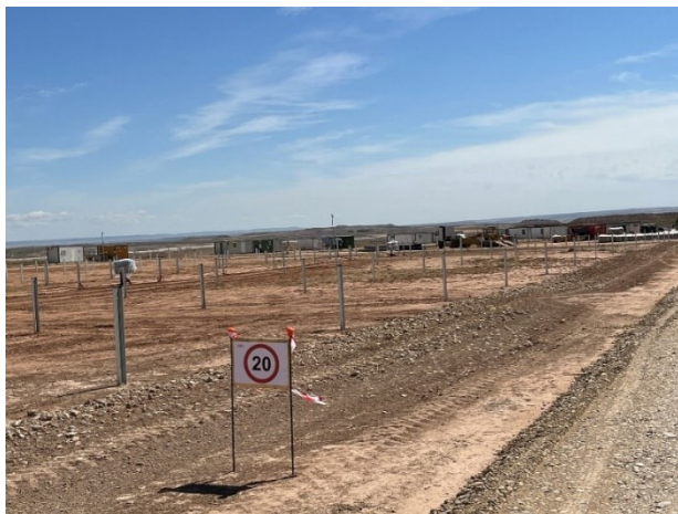
Figura 3 Señalización en obra
