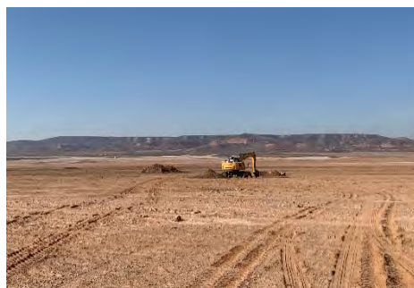
Figura 3 Apertura de zanjas
