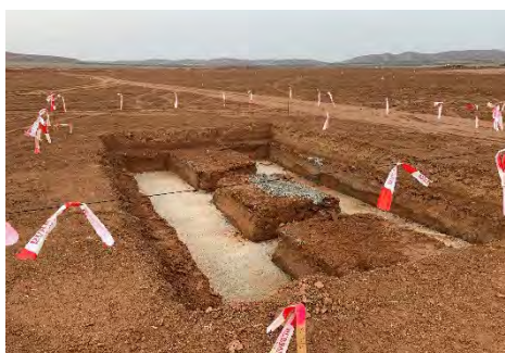
Figura 4 Trabajos de cimentación
