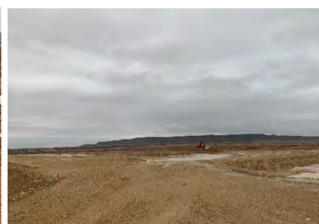
Figura 5 Apertura de viales
