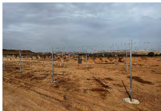
Figura 34 Instalación del vallado perimetral
