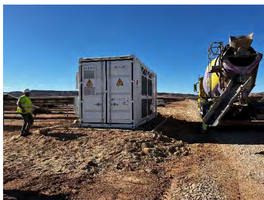
Figura 22 Labores de cimentación
