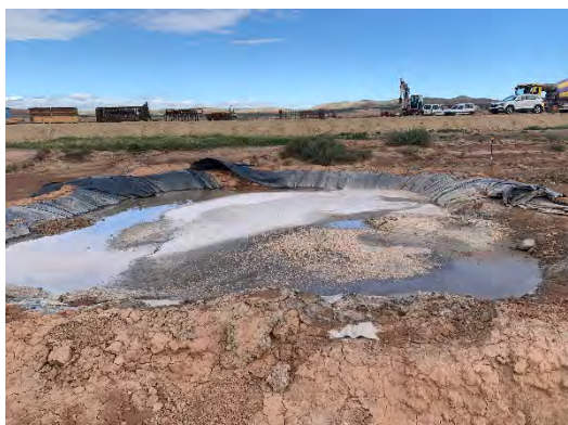
Figura 24 Lavadero de cubas de hormigón
