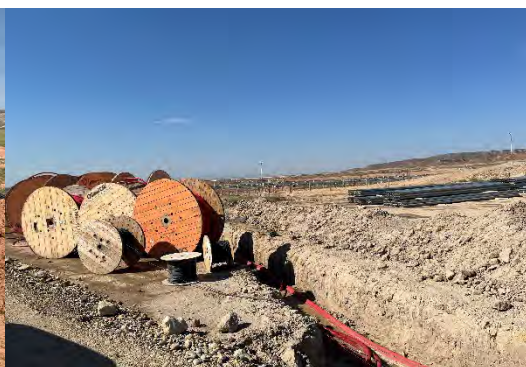
Figura 10 Tendido de cable de media tensión
