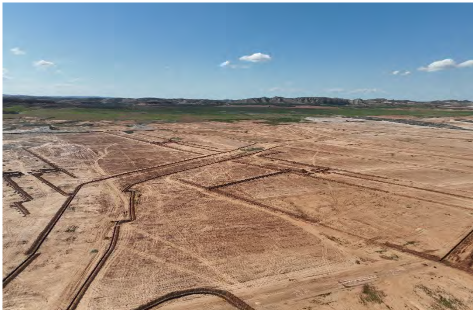
Figura 35 Apertura de zanjas
