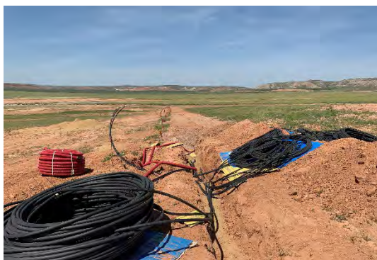
Figura 9 Tendido de cable de baja tensión
