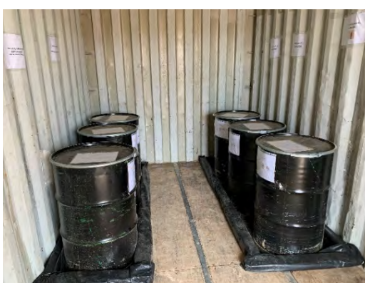
Figura 27 Punto limpio de residuos peligrosos
