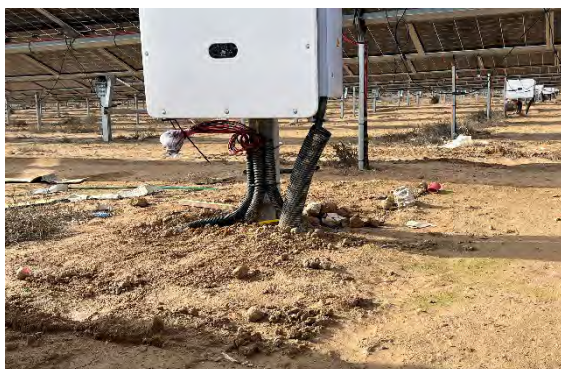
Figura 11 Montaje de los inversores
