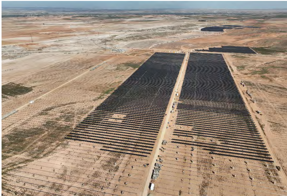
Figura 37 Montaje de los módulos
