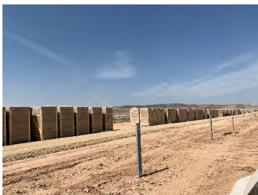
Figura 26 Acopio del material de construcción
