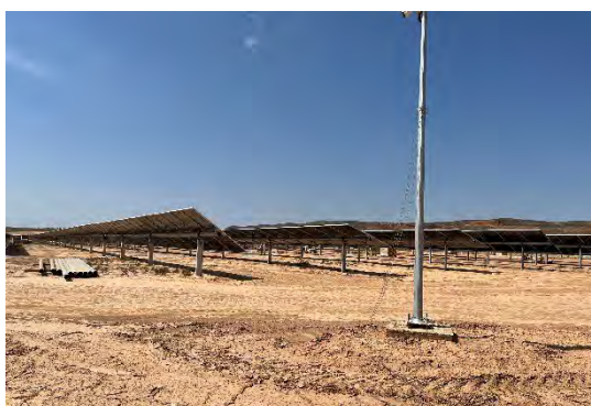
Figura 8 Montaje de los módulos fotovoltaicos
