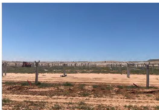
Figura 7 Montaje de los trackers
