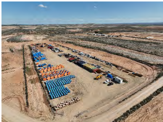
Figura 18 Zona de acopio del material de construcción
