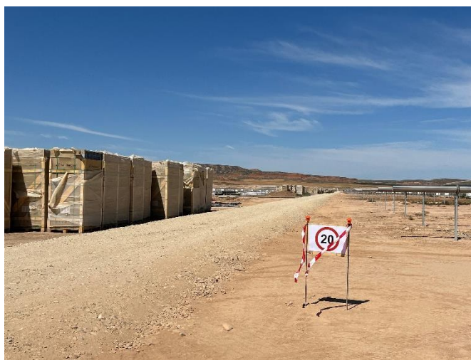
Figura 7 Señalización en obra
