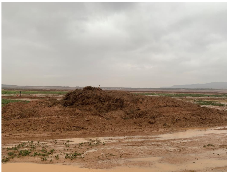
Figura 4 Acopio de tierra vegetal
