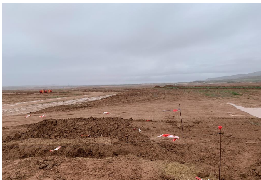
Figura 8 Zanjas para la RMT
