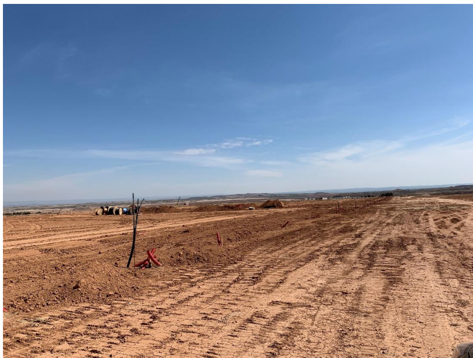
Figura 3 Cableado de la RMT
