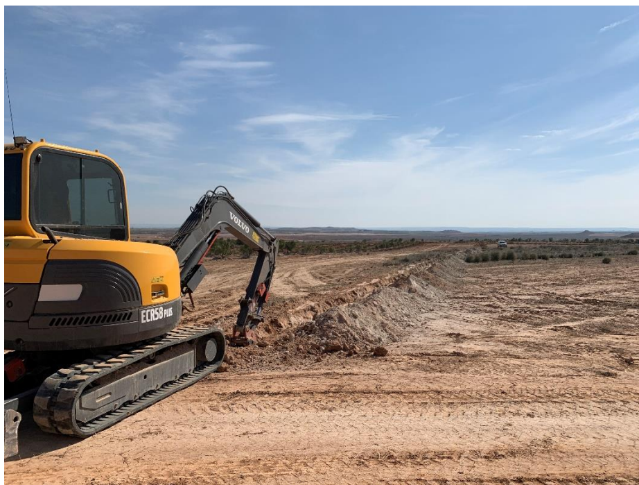
Figura 2 Apertura de zanjas
