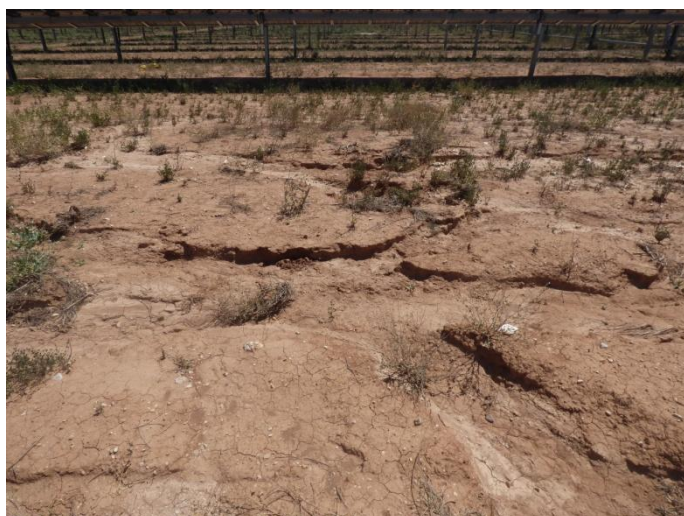
Imágenes 1 y 2 : Regueros locales de pequeña entidad bajolos paneles solares.
