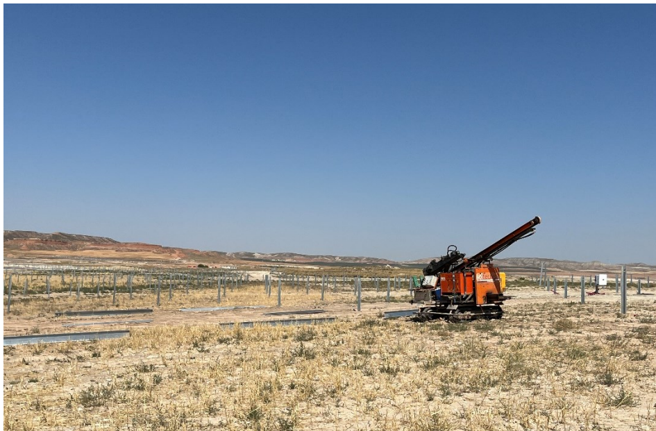
Figura 7 Zona de acopio
