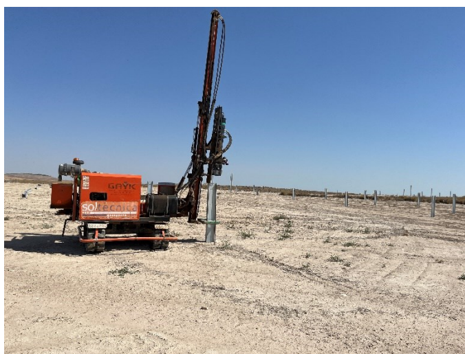
Figura 3 Labores de hincado
