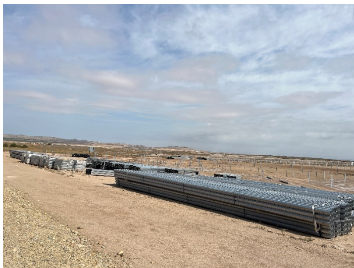
Figura 4 Acopio de material de construcción
