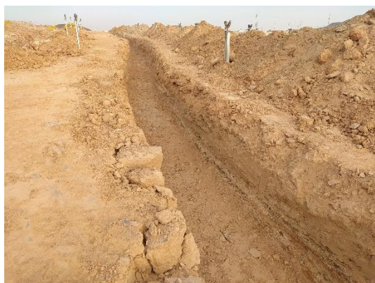
Fot. 1 y 2. Zanja de BT y retales paralelos al vial 2 de Pitarco A
