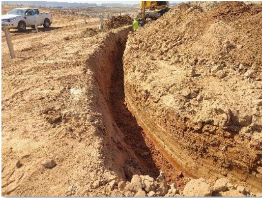
Fot 3 y 4. Zanja de BT ente la PSFV Pitarco A
