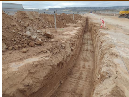
Fot 3 y 4. Zanja de BT al norte de vial 2, junto a la zona- 5 de la PSFV Pitarco A Norte
