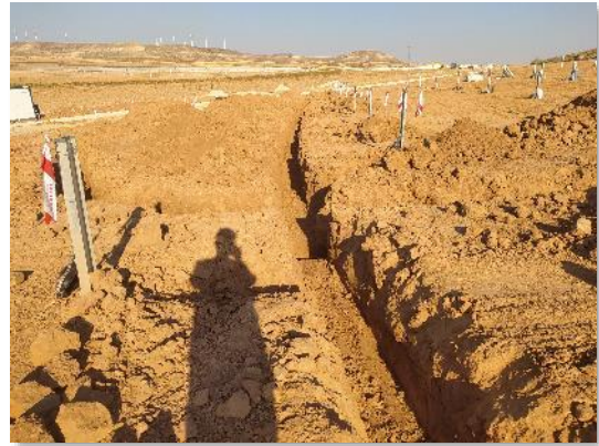
Fot 3 y 4. Zanja de BT ente la PSFV Pitarco A
