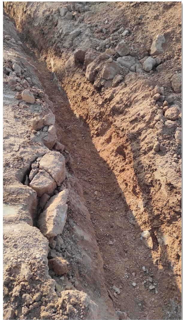
Fot 3 y 4. Zanja de BT al norte de la zona de exclusión arqueológica, junto a la zona 4 de la PSFV Pitarco A Norte
