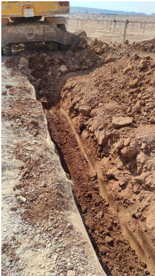
Fot. 1 y 2. Zanja de MT y retales paralelos al vial 2 de Pitarco A
