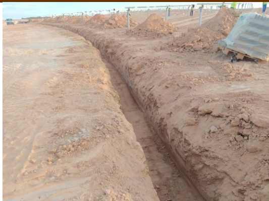
Fot 3 y 4. Zanja de BT al norte de vial 2, junto a la zona- 5 de la PSFV Pitarco A Norte
