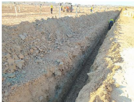
Fot. 1 y 2. Zanja de MT en el vial 2 de Pitarco A
