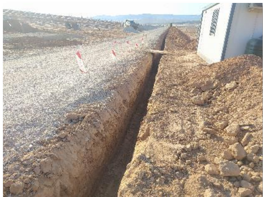
Fot. 1 y 2. Zanja de MT en el vial 2 de Pitarco A
