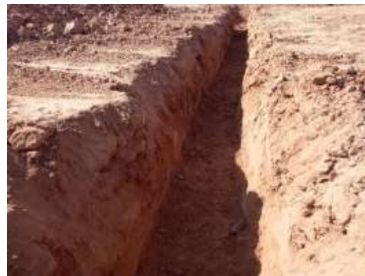
Fot. 1 y 2. Realización del zanjeo de BT en Zonas 8 y 9 de PSFV Pitarco A Oeste
