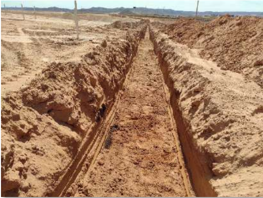
Fot 3 y 4. Zanja de MT en Pitarco C
