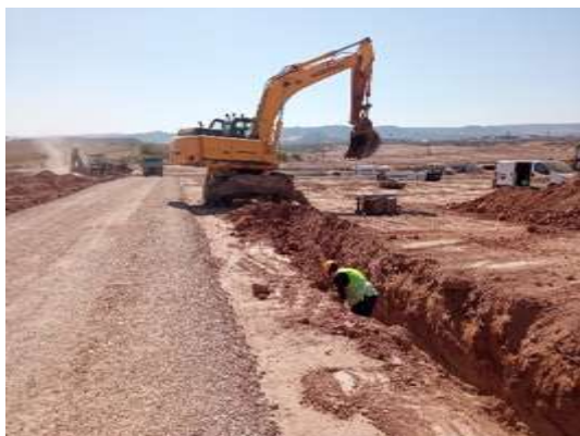
Fot. 3 y 4 Realización del zanjeo de BT en Zonas 8 y 9 de PSFV Pitarco A Oeste
