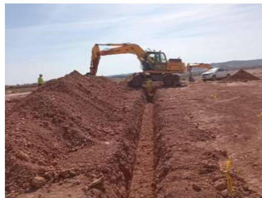
Fot. 3 y 4 Realización del zanjeo de BT en Zonas 8 y 9 de PSFV Pitarco A Oeste
