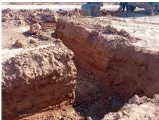
Fot. 1 y 2. Realización del zanjeo de BT en Zonas 8 y 9 de PSFV Pitarco A Oeste
