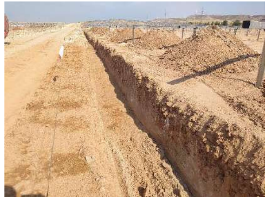
Fot. 1 y 2. Zanja de BT de Pitarco A
