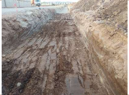
Fot 2. Zanja de MT de Vial 2 a Subestación PSFV Pitarco A
