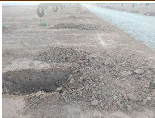
Fot 1 y 2. Zanja retal a Zanjeo de BT y MT entre Sectores B1 y B2 de PSFV Pitarco B
