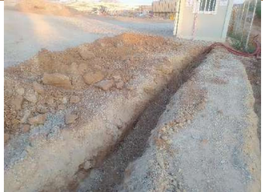
Fot 5 y 6. Zanqueo cimentación de puerta de acceso a PSFV Pitarco A
