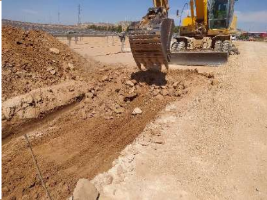
Fot 2. Zanja de MT de Vial 2 a Subestación PSFV Pitarco A
