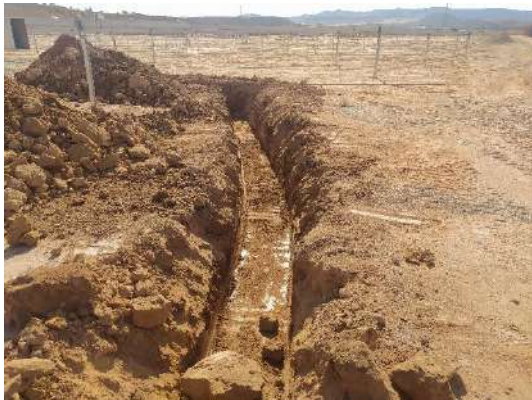
Fot. 1 y 2. Zanja de BT de Pitarco A
