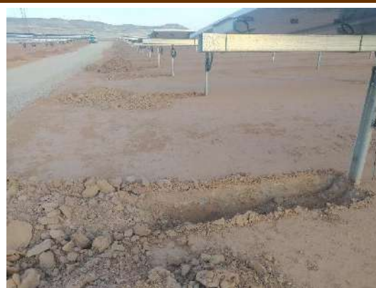
Fot 1 y 2. Zanja retal a Zanjeo de BT y MT entre Sectores B1 y B2 de PSFV Pitarco B
