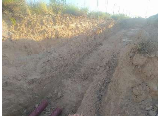
Fot 5 y 6. Zanjeado para evacuación entre SET Polígono Pitarco y PSFV Pitarco A
