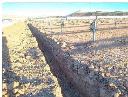
Fot 1. Zanjeo a lo largo del vial 2 en Sector 5 PSFV Pitarco A
