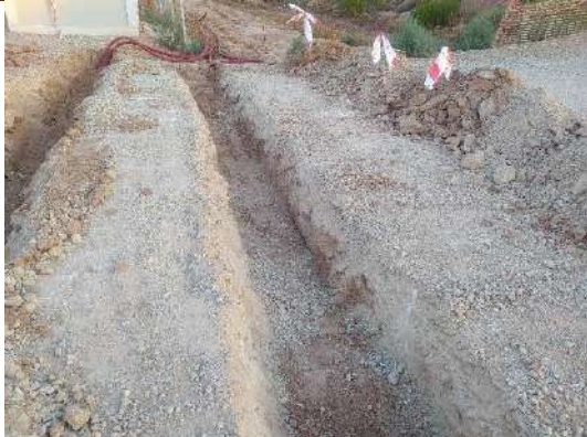
Fot 5 y 6. Zanjeo cimentación de puerta de acceso a PSFV Pitarco A
