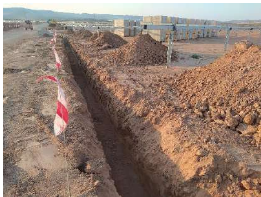
Fot. 1 y 2. Zanja de MT de Pitarco A
