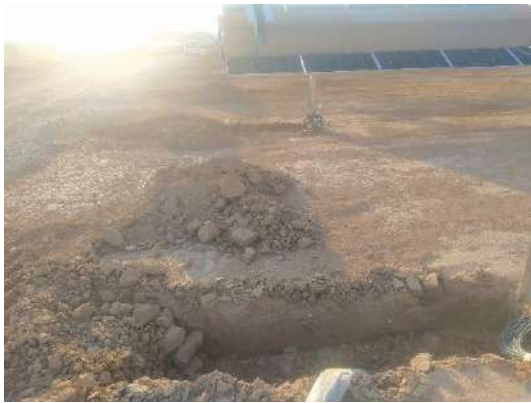
Fot 3, 4. Zanja retal a Zanjeo de BT y MT entre Sectores B1 y B2 de PSFV Pitarco B
