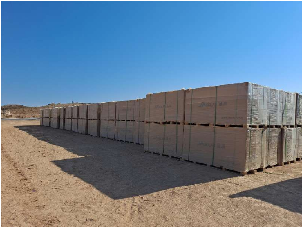
Zona de acopio palets de paneles fotovoltaicos
