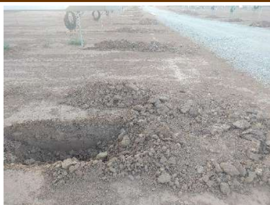
Fot 1 y 2. Zanja retal a Zanjeo de BT y MT entre Sectores B1 y B2 de PSFV Pitarco B
