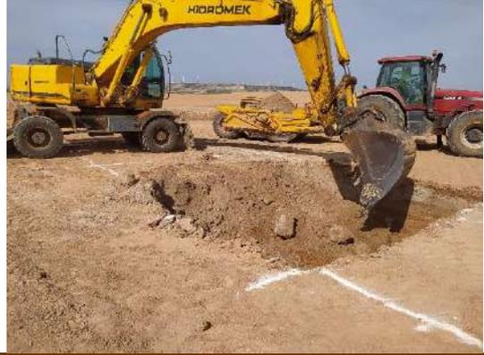
Fot 3 y 4. Trabajos de excavación en transformador de la Subestación en PSFV Pitarco A
