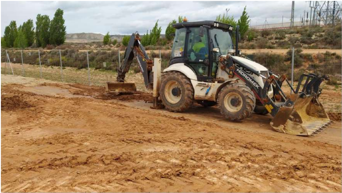
Fot. 7. Rebaje para la evacuación de agua junto a CAMPA.
