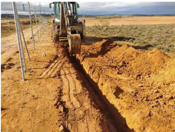
Fot. 3 y 4. Zanja para CCTV junto a poligonal en Sectores 5 y 7.
