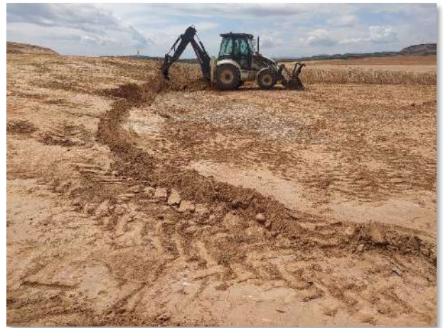
Fot. 1 y 2. Trabajos de acondicionamiento del solar para la SET junto a la CAMPA de la PFV Pitarco A
