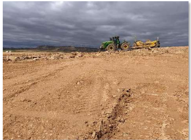
Fot. 1 y 2. Trabajos de rebaje de geológico y refinado en el sector 2 de Pitarco A
