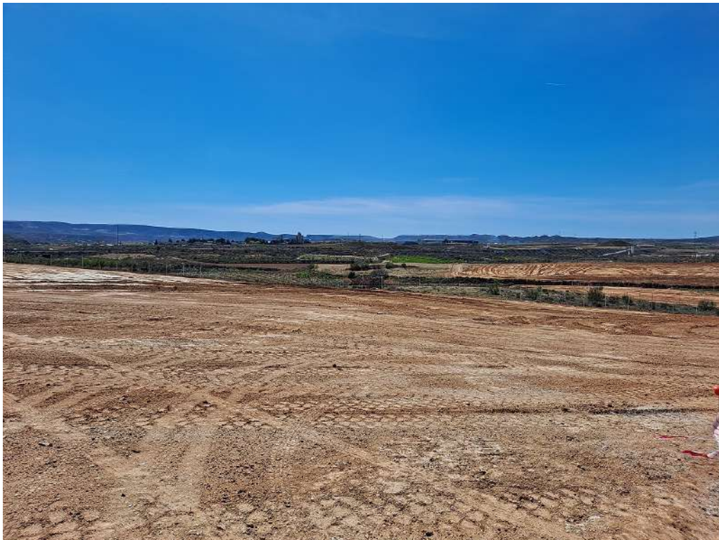
Trabajos de nivelado y repaso antes del hincado
