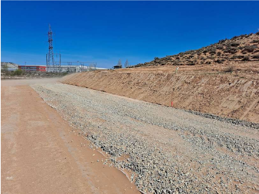
Vial interno de acceso acondicionado con capa geotextil y gravilla
