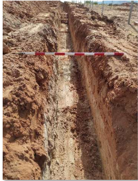
Fot. 3 y 4. Zanja para CCTV junto a poligonal en Sectores 3, 5 y 7.
