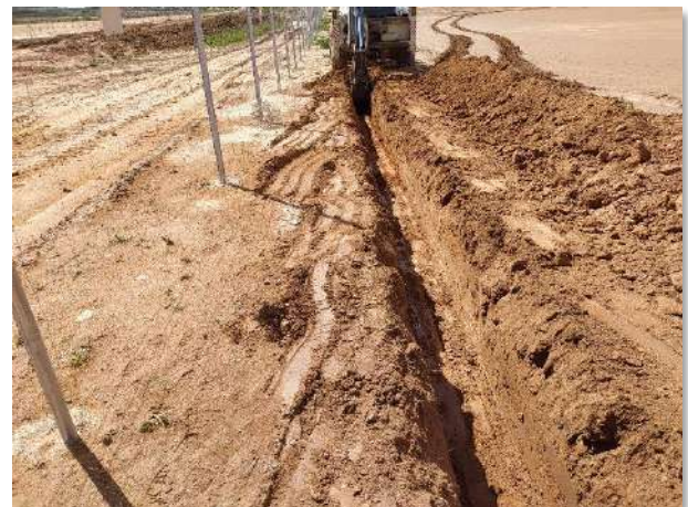
Fot. 3 y 4. Zanja para CCTV junto a poligonal en Sectores 5 y 7.
