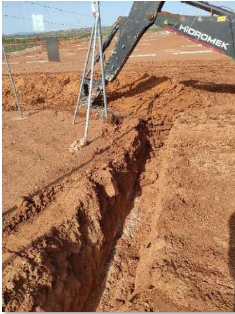
Fot. 3 y 4. Zanja para CCTV junto a poligonal en Sectores 3, 5 y 7.
