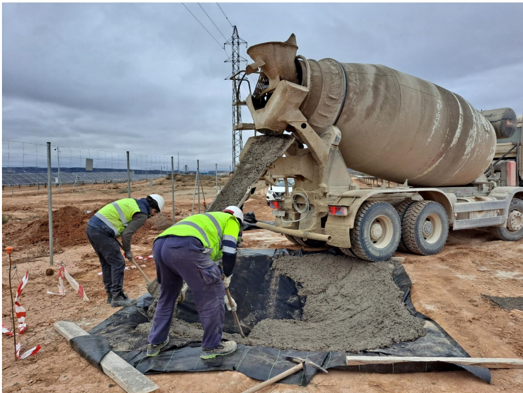
Foto 6. Lámina impermeable e impermeabilización de la balsa
