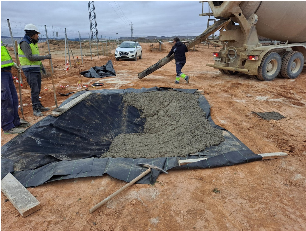
Foto 6. Lámina impermeable e impermeabilización de la balsa
