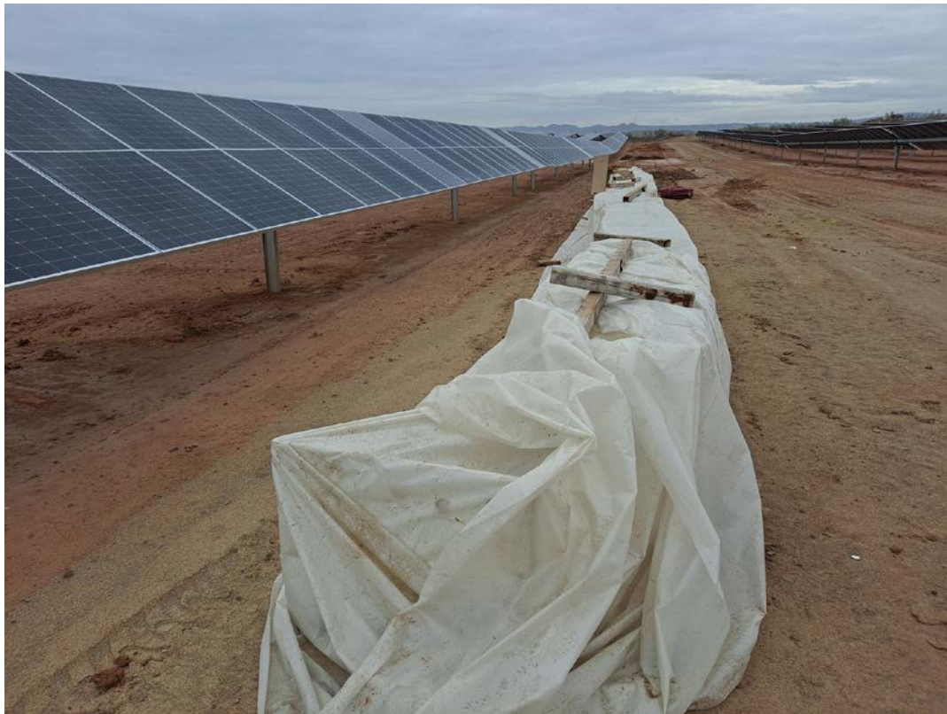
Foto 4. Recogida de agua de lluvia en la bandeja antiderrame a tratar como residuo
