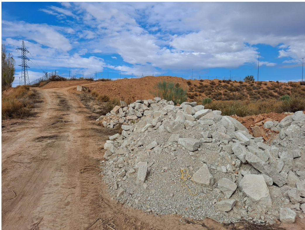
Foto 6. Acopio de RCD de hormigón no supera los 2 metros
