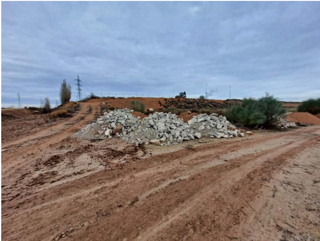
Foto 6. Acopio de RCD de hormigón no supera los 2 metros
