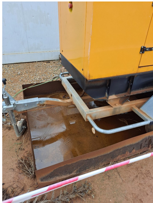
Foto 4. Recogida de agua de lluvia en la bandeja antiderrame a tratar como residuo
