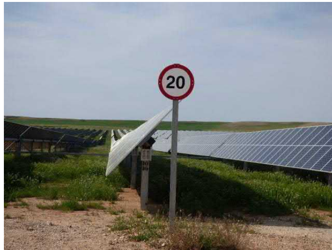
Imagen 9: Señal de límite de velocidad situada en el interior de los viales internos del parque fotovoltaico.
