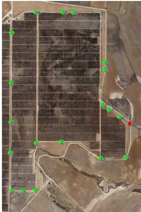
Figura 1: Mapa con la ubicación de las torres de vigilancia con cableado expuesto junto con los códigos adjudicados para su identificación (georreferenciado por el técnico de medio ambiente). Torretas con cableado expuesto (círculos rojos), torretas con cableado no expuesto (círculos verdes).
