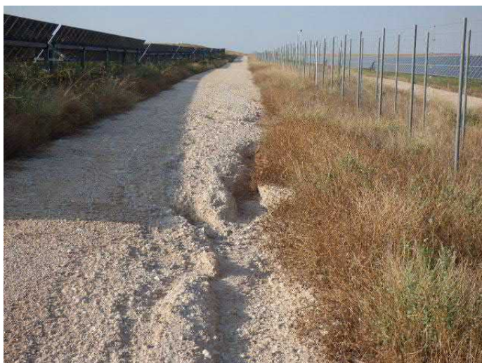
Imágenes 1 y 2 : Signo de erosión dentro del vial interno del parque fotovoltaico Híjar I.
