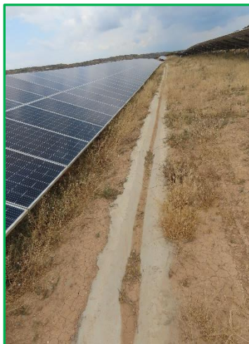
Figura 3. Cuneta hormigonada de aspecto correcto.
