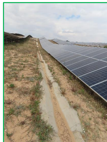
Figura 4. Cuneta hormigonada de aspecto correcto
