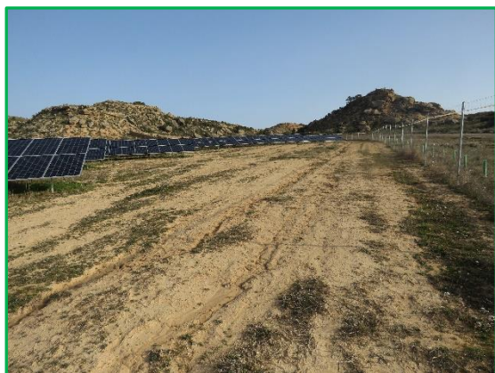
Figura 3. Pequeña cárcava paralela al vallado
