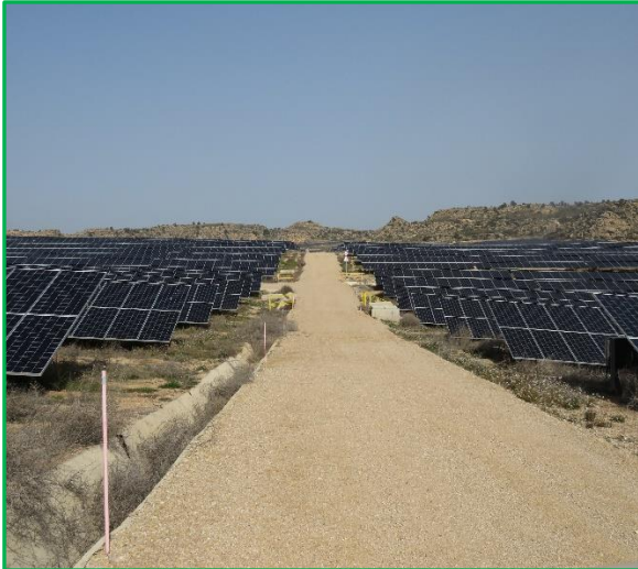
Figura 11. Cunetas cimentadas con restos de capitanas
