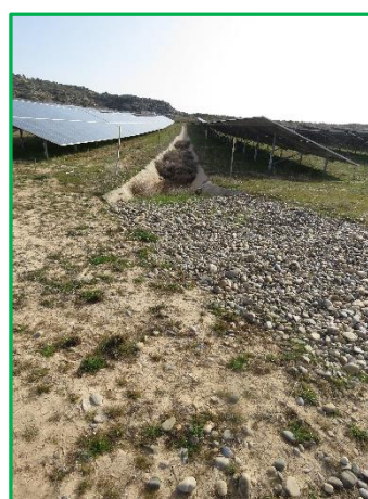
Figura 6. Cárcava consolidada con cantos rodados
