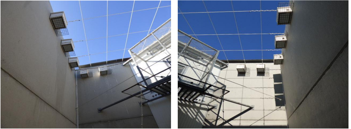
Imágenes 17, 18 y 19: Interior del primillar.
