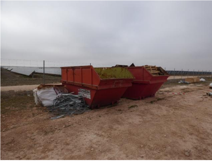
Imágenes 23 y 24: Contenedor de residuos no peligrosos sin etiquetado correspondiente (izquierda). Residuos de obra depositados fuera de los contenedores habilitados (derecha).
