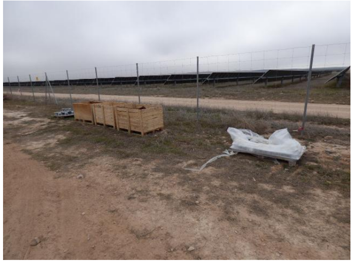
Imágenes 23 y 24: Contenedor de residuos no peligrosos sin etiquetado correspondiente (izquierda). Residuos de obra depositados fuera de los contenedores habilitados (derecha).
