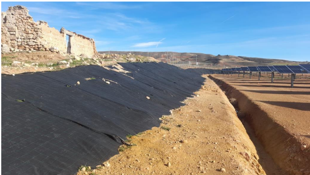
Talud pendiente de revegetación
