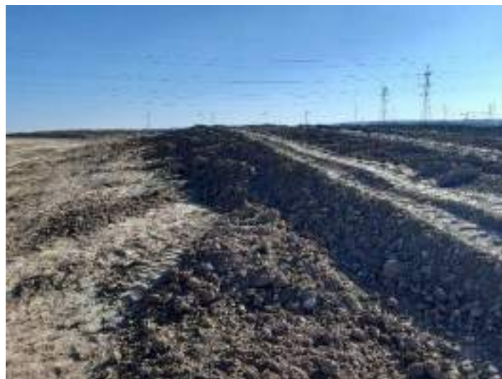
Acopio temporal de tierra vegetal en la parcela norte.
