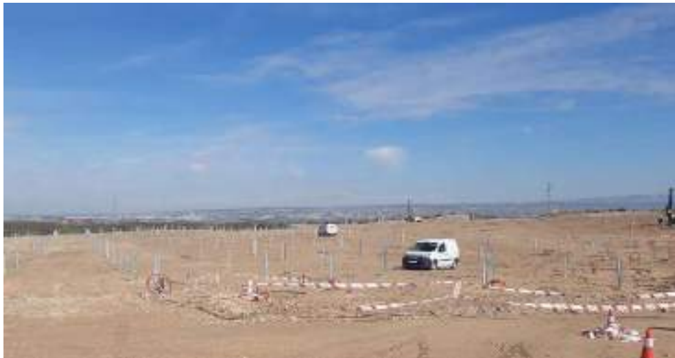
Hincado de soportes de los paneles en la parcela norte
