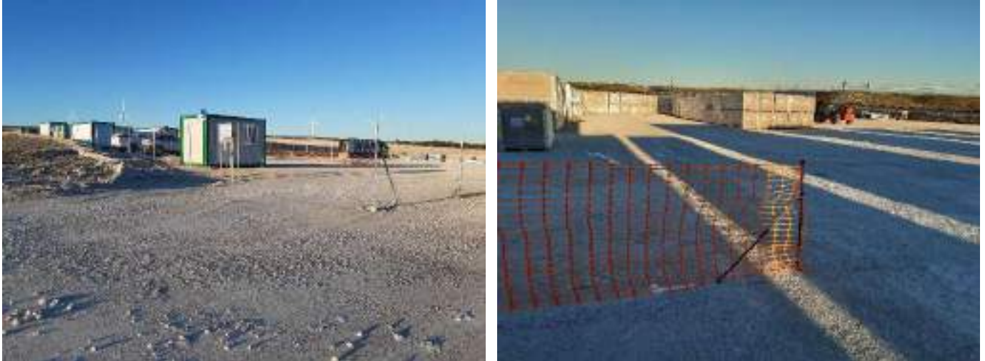
Campa de obras ya casi montada, en donde se empiezan a acopiar elementos.
