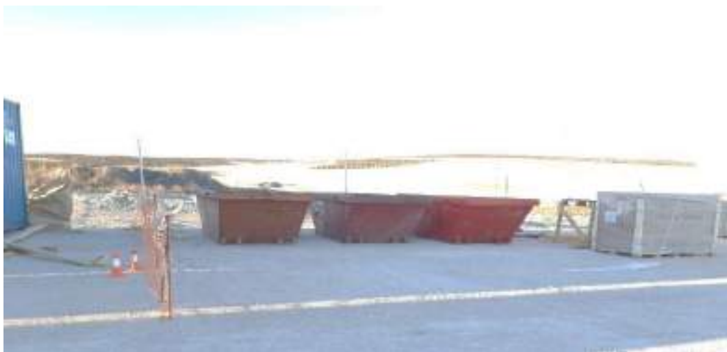
Punto limpio de RNP, en fase de instalación.
