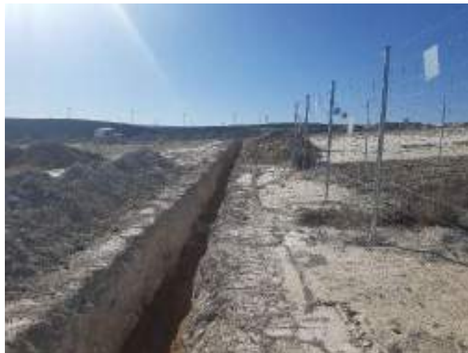
Ejecución de zanjas, en el interior de la parcela sur.
