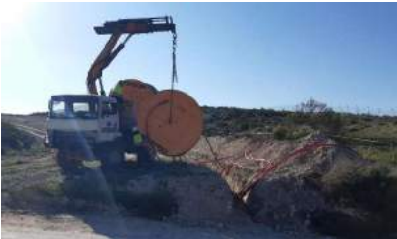
Trabajos de tendido de cables en la zanja.
