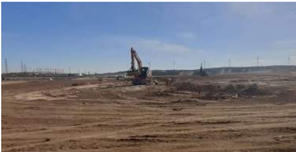
Trabajos en las zanjas interiores de la parcela sur.
