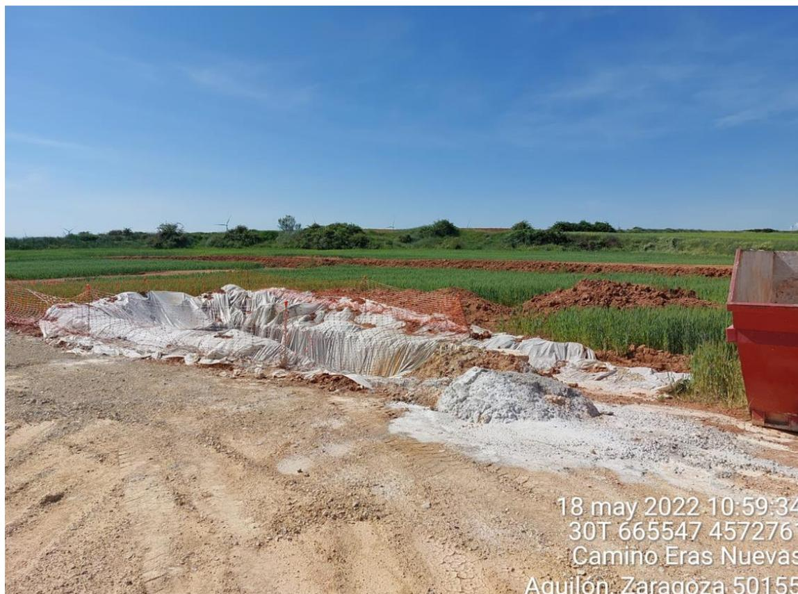
Imagen 1. Residuo de hormigón evidente en pozo de lavado SB1-7.
