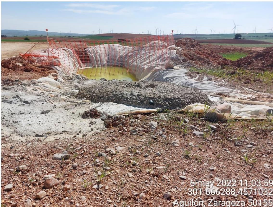
Ilustración 1. No conformidad grave. Pozo de lavado utilizado sin impermeabilizar el suelo.
