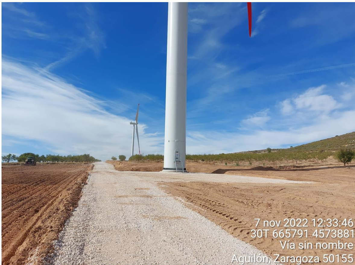
Imagen 4. Posición SBI-02 durante su restauración.
