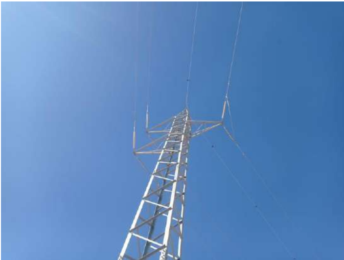
Fotos 19 y 20: Detalle de los dispositivos salvapájaros
