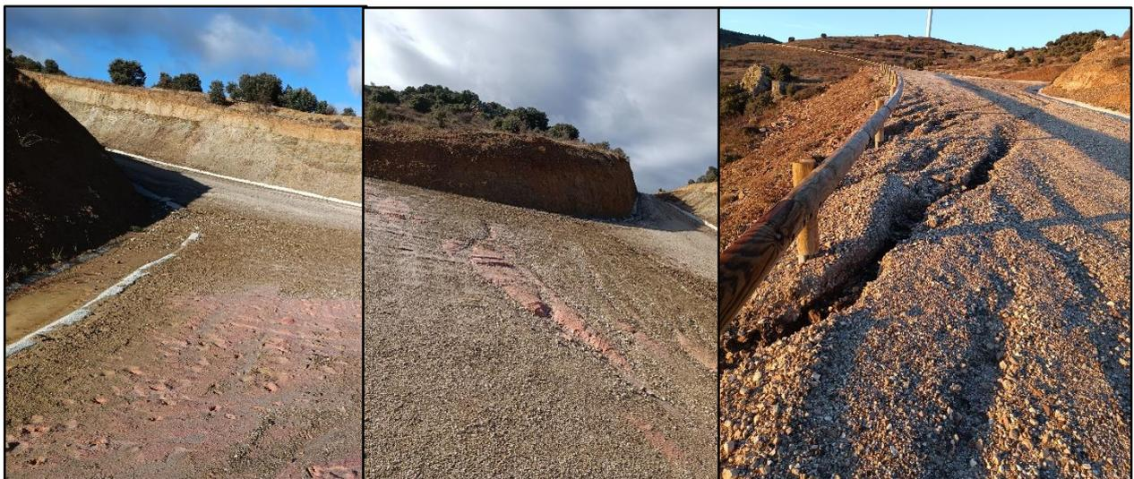
**Fotografía 2.** Proceso de colmatación de la cuneta del vial principal a la altura de la turbina PDH03 por desprendimiento de material fino y el proceso erosivo asociado produciendo regueros de tamaño considerable en el vial principal.
