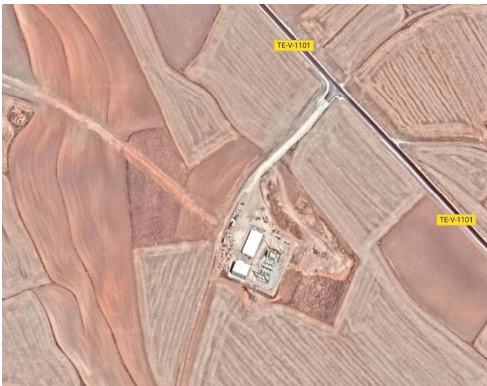
Figura 2: Subestación eléctrica sobre foto aérea
