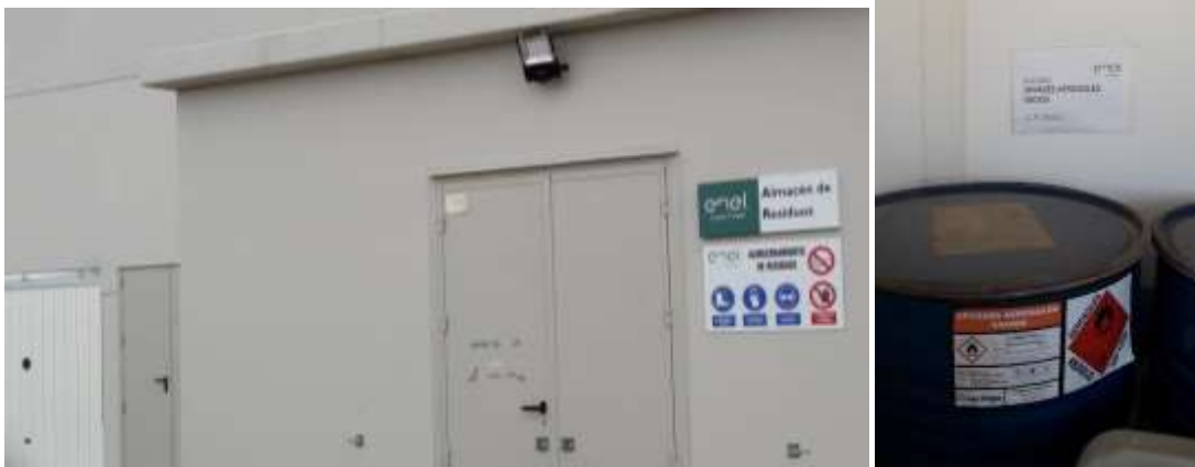
Punto limpio habilitado en la subestación Ventavieja para los parques eólicos de Muniesa, San Pedro de Alacón y Farlán
