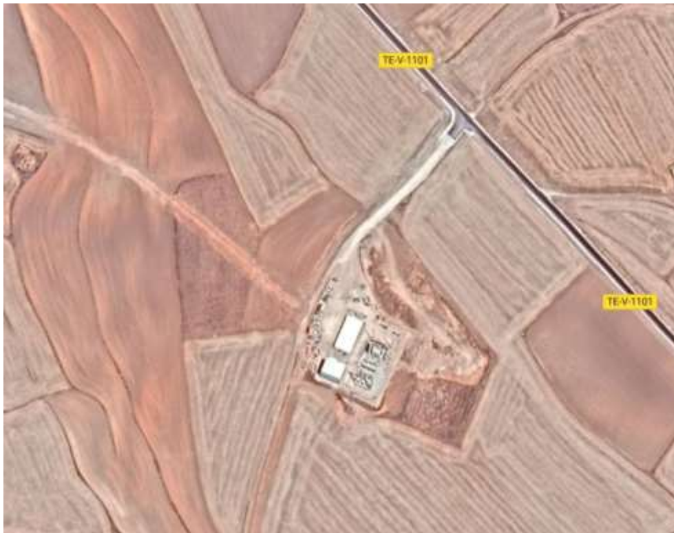
Figura 2: Subestación eléctrica sobre foto aérea
