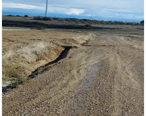
Figura 1: Tubo de drenaje taponado por sedimentos en vial de acceso al aero ML5.01 antes y después de los trabajos de limpieza.
