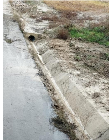
Figura 4: Tubo de drenaje semitaponado con vegetación arbustiva en vial de acceso al aero ML5.05 antes y después de los trabajos de limpieza.
