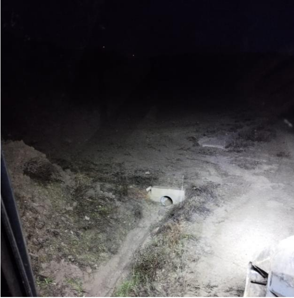
Figura 7: Tubo de drenaje taponado con sedimentos en vial de acceso al aereo ML5.09 antes y después de los trabajos de limpieza.
