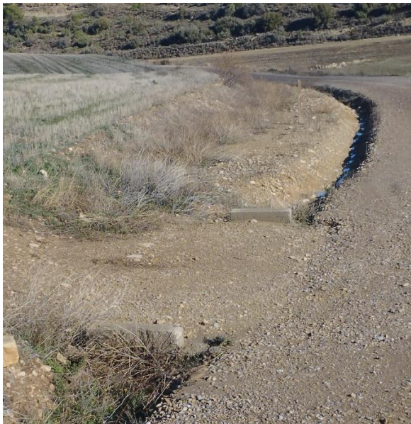
Figura 2: Tubo de drenaje taponado por sedimentos en vial de acceso al aero ML5.01 antes y después de los trabajos de limpieza.
