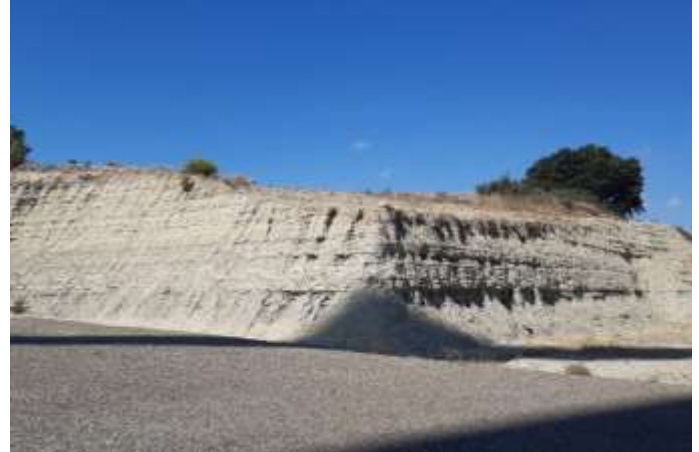
Fig. 2 Erosión hídrica en materiales margo-calizos del talud de desmonte de la plataforma del aero MLA5.07. Elaboración propia
