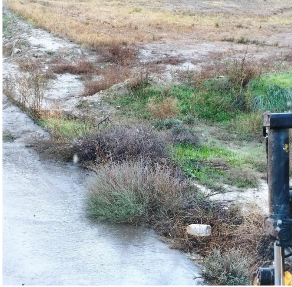
Figura 5: Tubo de drenaje semitaponado con vegetación arbustiva en vial de acceso al aero ML5.06 antes y después de los trabajos de limpieza.
