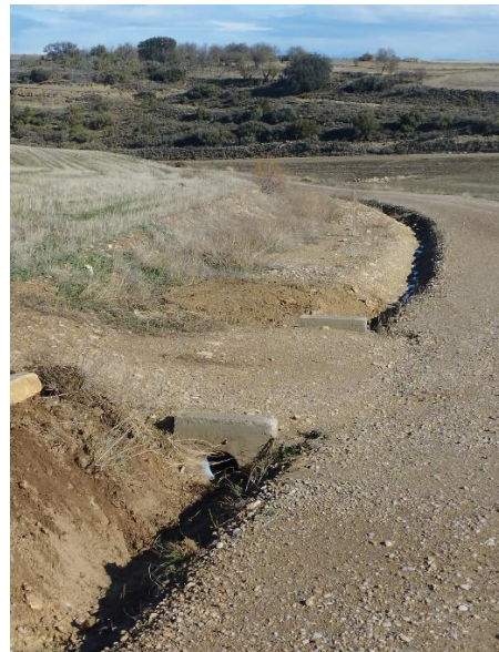
Figura 2: Tubo de drenaje taponado por sedimentos en vial de acceso al aero ML5.01 antes y después de los trabajos de limpieza.
