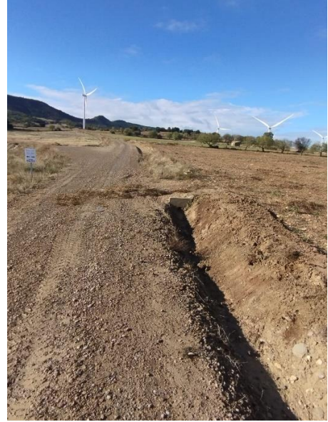
Figura 3: Tubo de drenaje taponado por sedimentos en vial de acceso al aero ML5.01 antes y después de los trabajos de limpieza.
