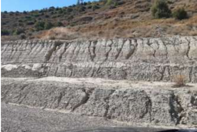
Fig. 1 Erosión hídrica en materiales margo-calizos del talud de desmonte del vial de acceso a ML5.05. Fuente: Elaboración propia
