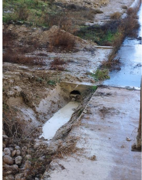
Figura 5: Tubo de drenaje semitaponado con vegetación arbustiva en vial de acceso al aero ML5.06 antes y después de los trabajos de limpieza.
