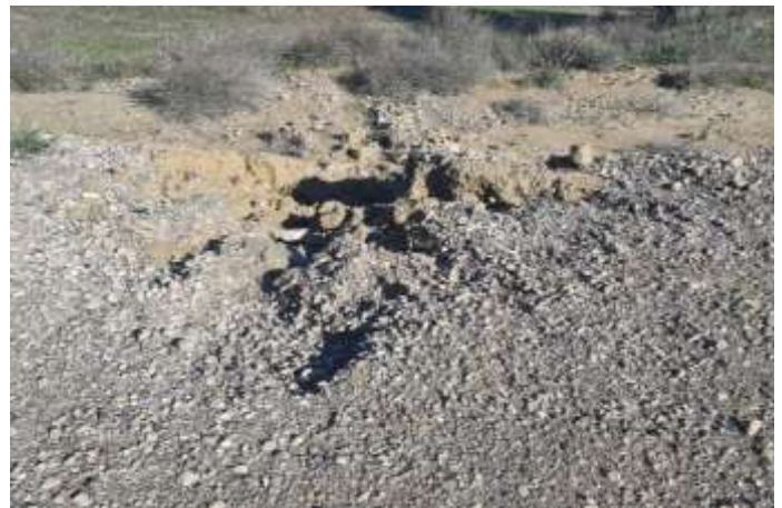
Fig. 6 Socavón en vial de acceso al aero ML5.08. Fuente: Elaboración propia
