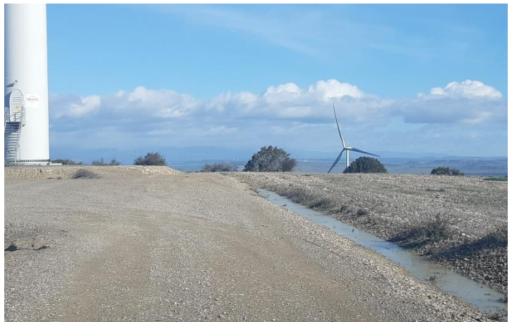
Fig. 2 Encharcamientos en margen de plataforma del aéro ML5.03. Fuente: Elaboración propia
