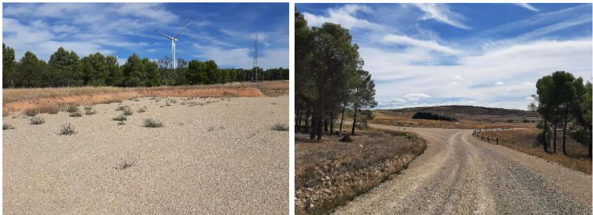
Plataforma de LG-02 y vial de acceso a LG-04, LG-05 y LG-06
