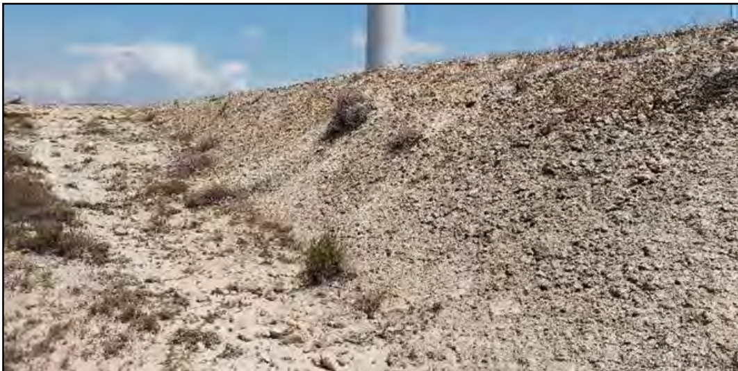
Fotografía 7. Talud con poca vegetación al sureste de la turbina
