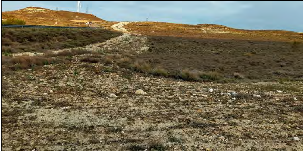
Fotografía 2. Estado de la revegetación en el acceso al aerogenerador HE01.
