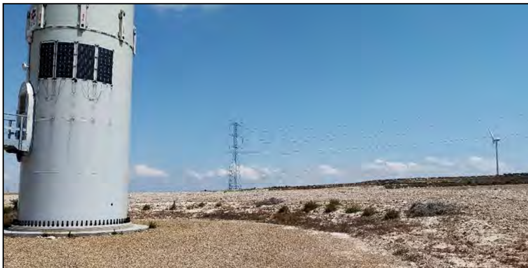
Fotografía 3. Pequeño talud junto a la turbina HE012
