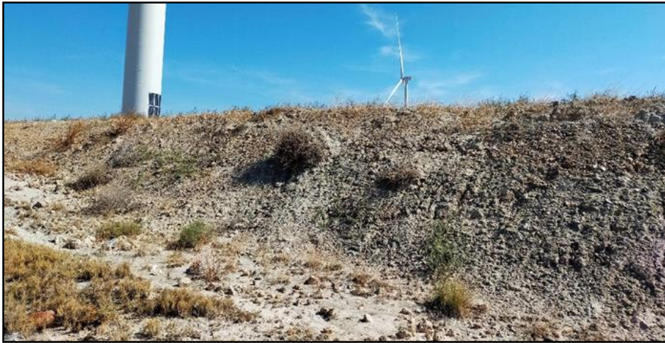
Fotografía 11. Talud con cierta pendiente junto a la turbina HE04
