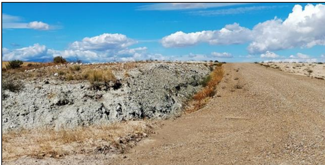
Fotografía 4. Desmonte para el acceso al aerogenerador HE-01.
