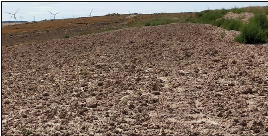
Fotografía 10. Zona hidrosembrada con escaso éxito de germinación.
