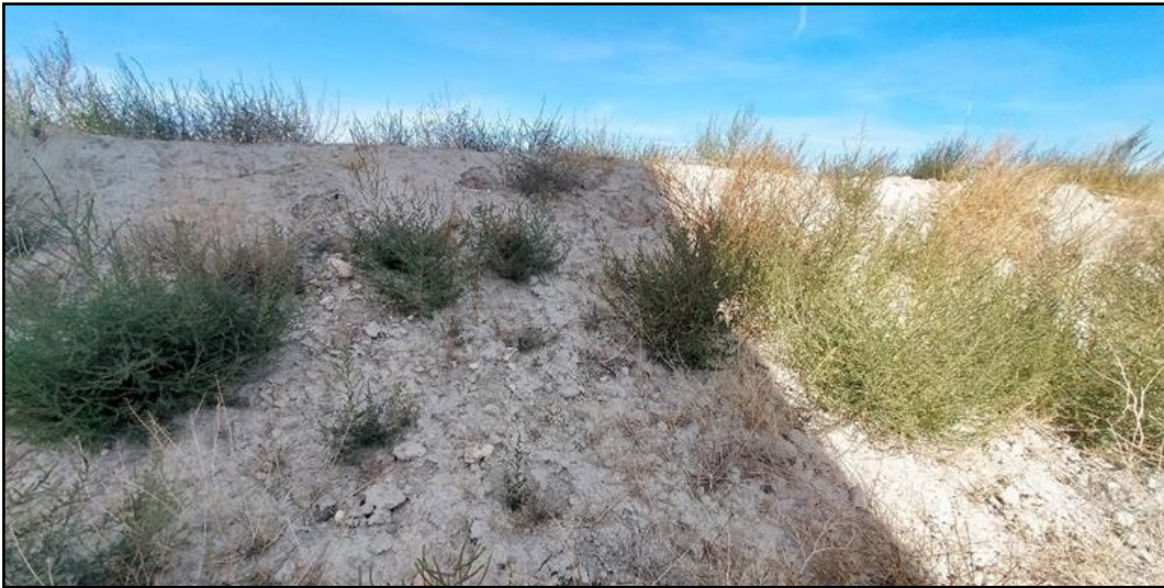
Fotografía 7. Vegetación sobre el talud de la turbina HE03.
