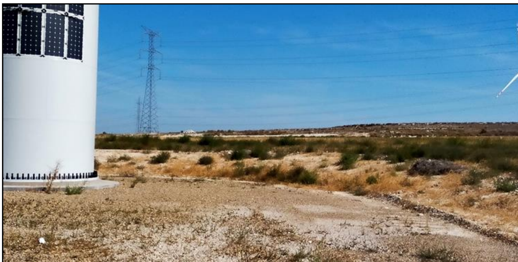
Fotografía 6. Aspecto del desmonte junto al aerogenerador HE02.
