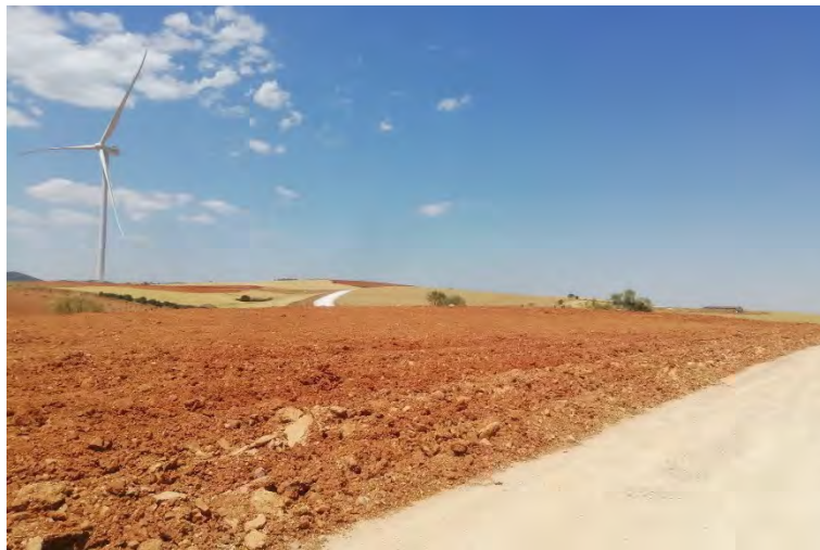
Foto 2 Restauración zonas auxiliares plataformas.
