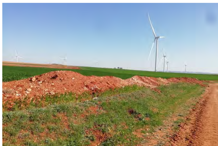
Foto 2 Acopios de tierra en la zanja hacia la SET.
