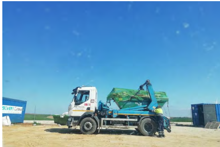
Foto 1 Retirada del contenedor de madera.
