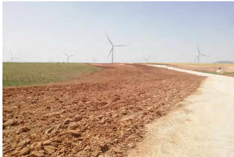
Foto 1 red de drenaje atravesando el vial.
