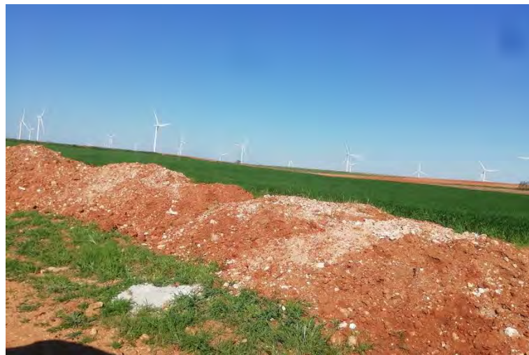
Foto 1 Acopios de tierra en la zanja hacia la SET.
