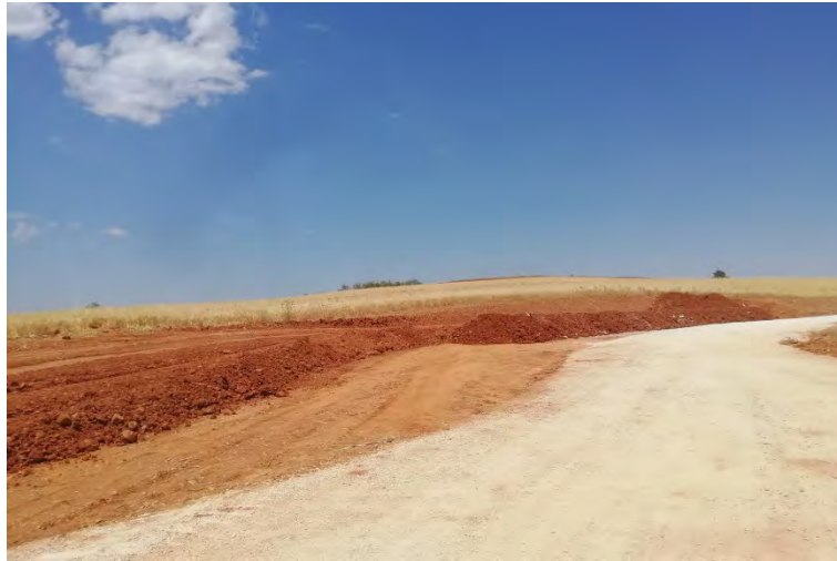
Foto 1 Restauración zonas auxiliares plataformas.
