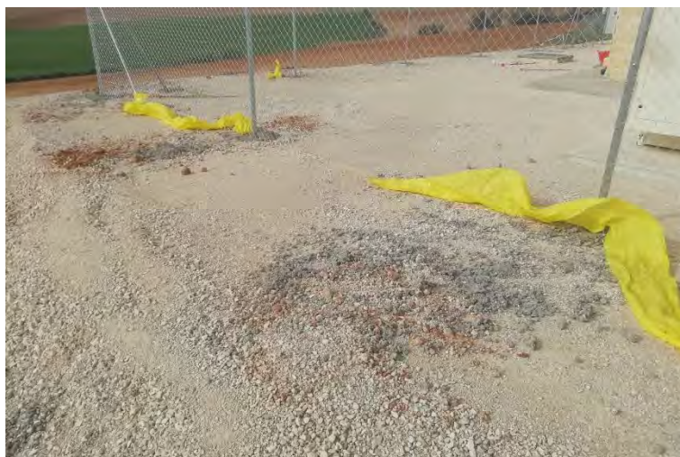
Foto 2 Residuos de hormigón y plásticos.
