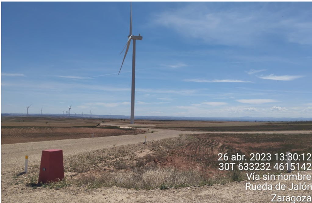
Figura 26: Estado de los viales de acceso al aerogenerador ET-2 y 3 hacia ET-4.
