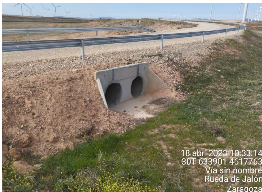
Figura 27: Desagüe situado en vial próximo a aerogeneradores ET11 y ET12 en buen estado.
