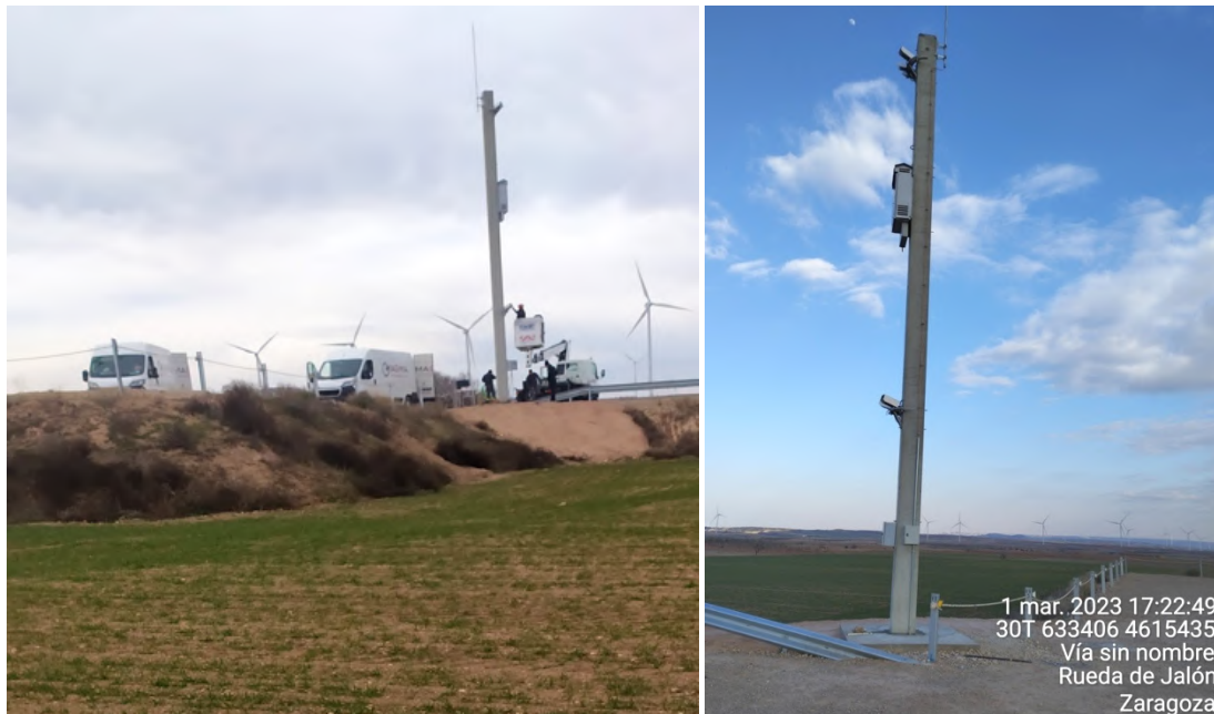
Figura 8: Fotografías de la instalación del Sistema “3D Observer” ubicado junto al aerogenerador ET-4 durante el primer cuatrimestre de 2023.
