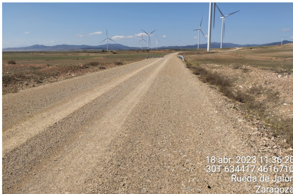
Figura 25: Vial de acceso principal entre aerogeneradores ET8 (aerogenerador más cercano de la imagen) y ET7. Puede observarse la vegetación natural arbustiva creciendo en los taludes.
