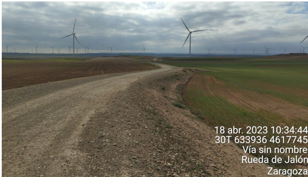
Figura 24: Vial de acceso a los aerogeneradores ET-11 y ET-12.
