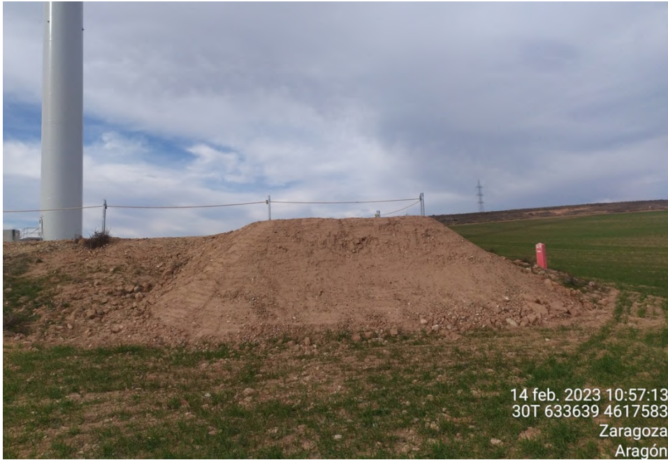
Figura 28: En los aerogeneradores ET-4 y ET-11 se tiene planeado instalar sistemas 3D Observer. El resultado de la restauración del talud de la base del sistema es el correcto.
