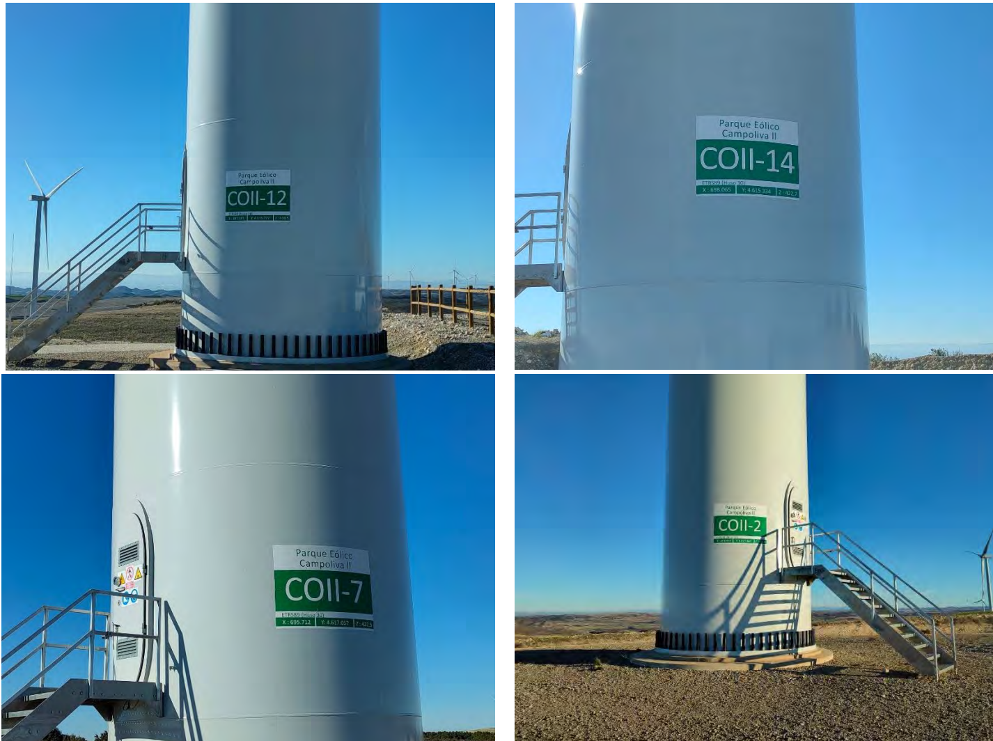
Fotografías 13 a 16: Señalización de las torres de los aerogeneradores
