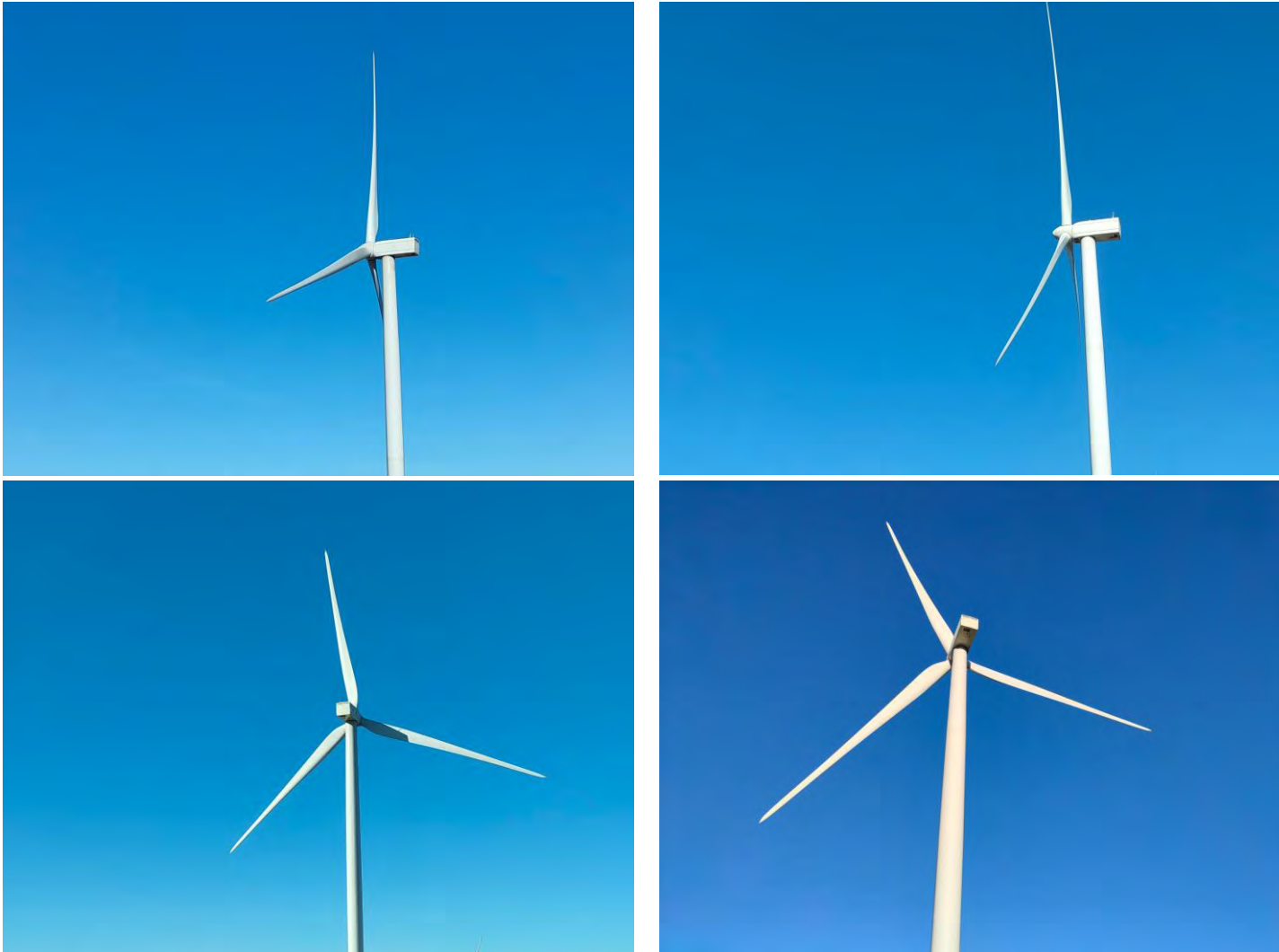
Fotografías 5 a 8: Barquillas de los aerogeneradores sin derrames de aceite
