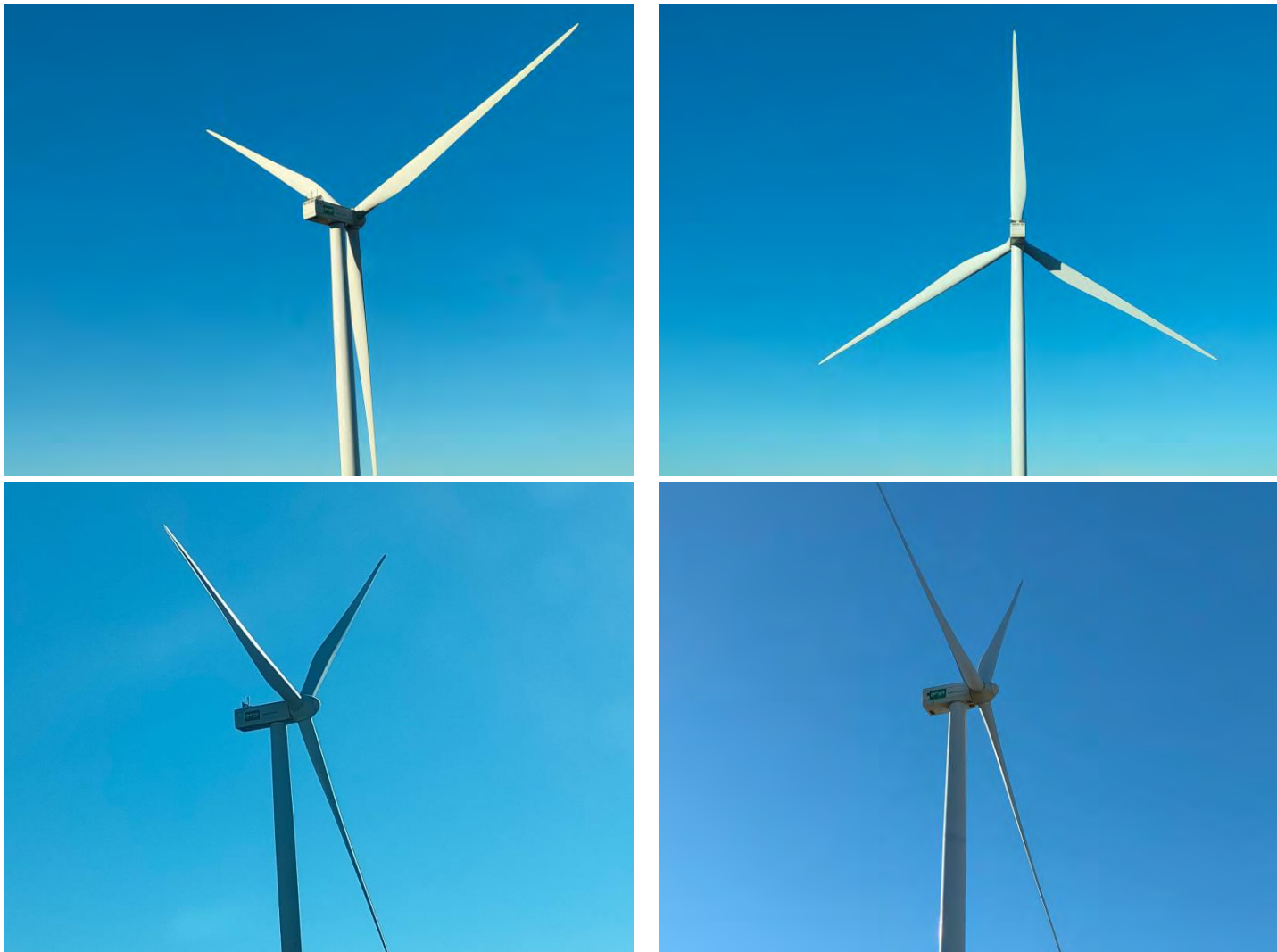
Fotografías 4 a 7: Barquillas de los aerogeneradores sin derrames de aceite
