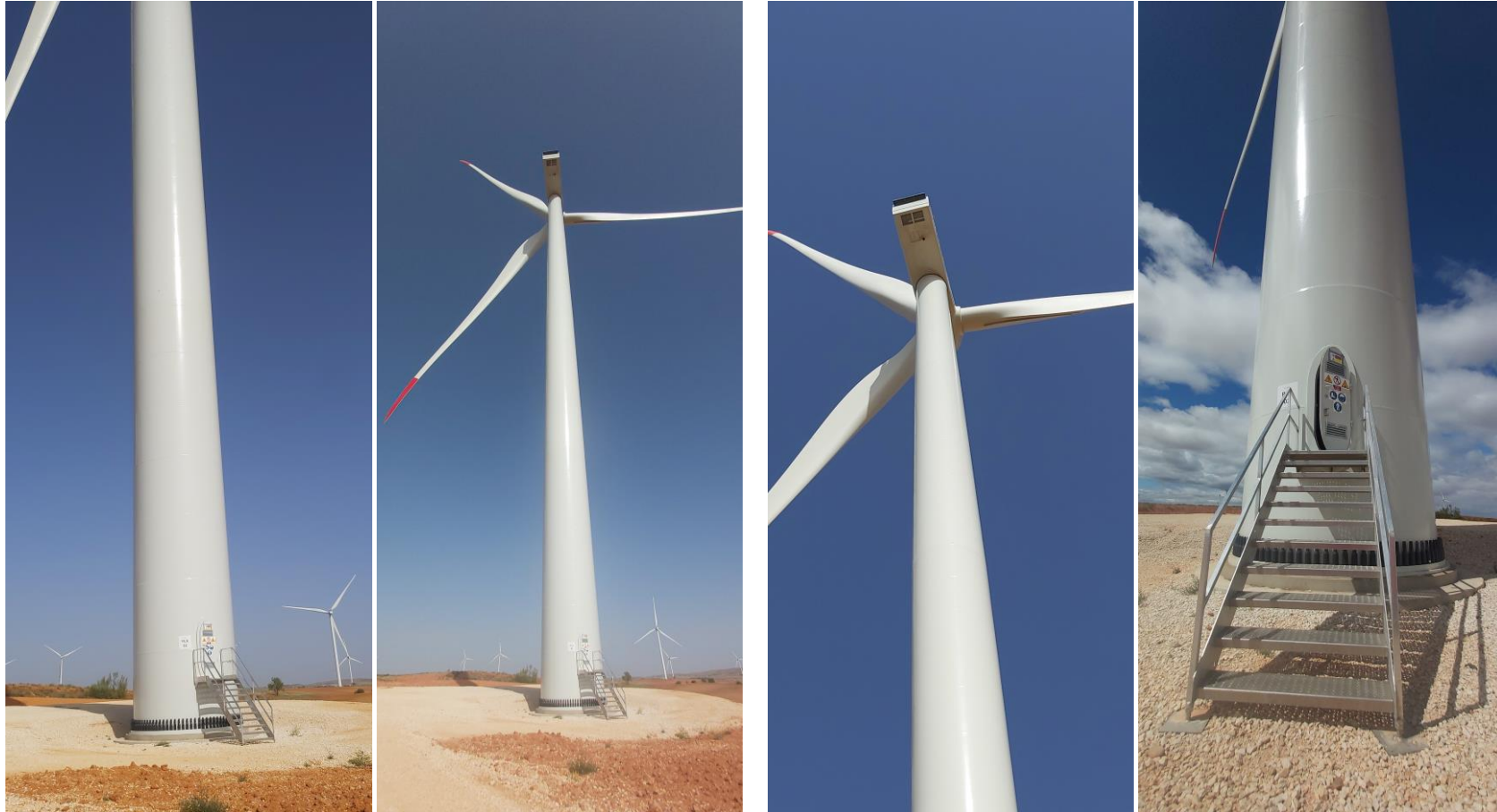
Fotografías 1 a 4: Estado de los aerogeneradores.
