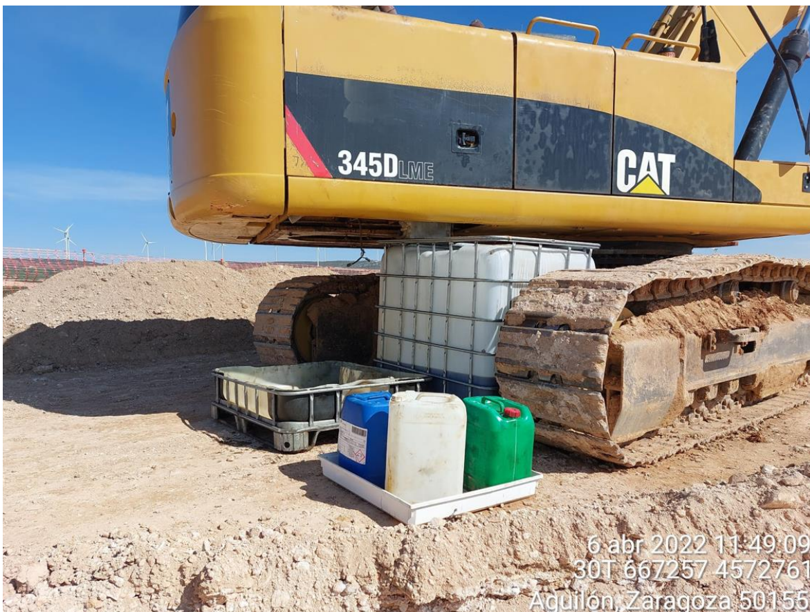
Imagen 5. Bidones colocados sobre cubetos de contención.
