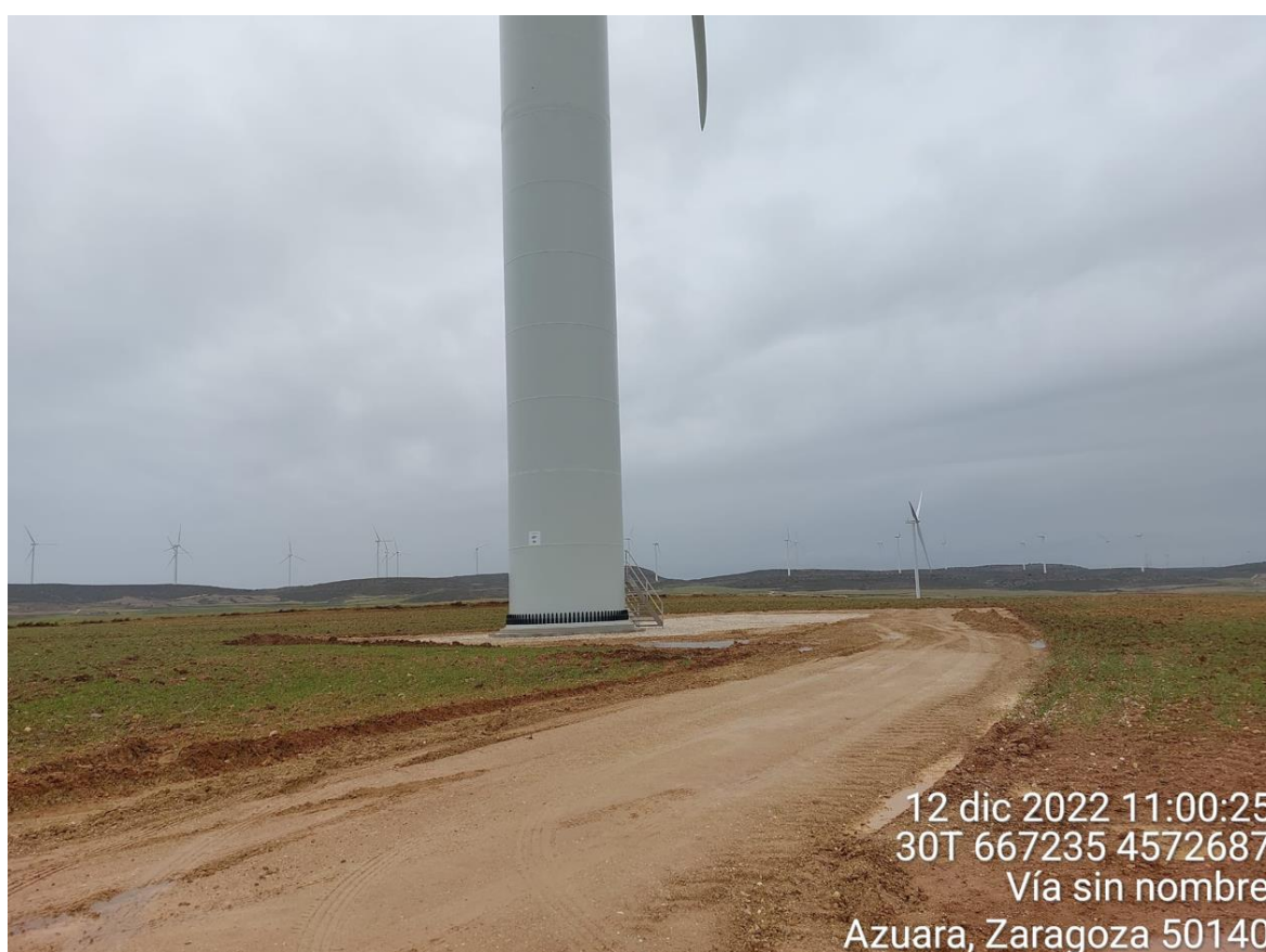
Imagen 1. Posición SBI-09 tras su restauración ambiental a falta de repararla para su aprobación definitiva.
