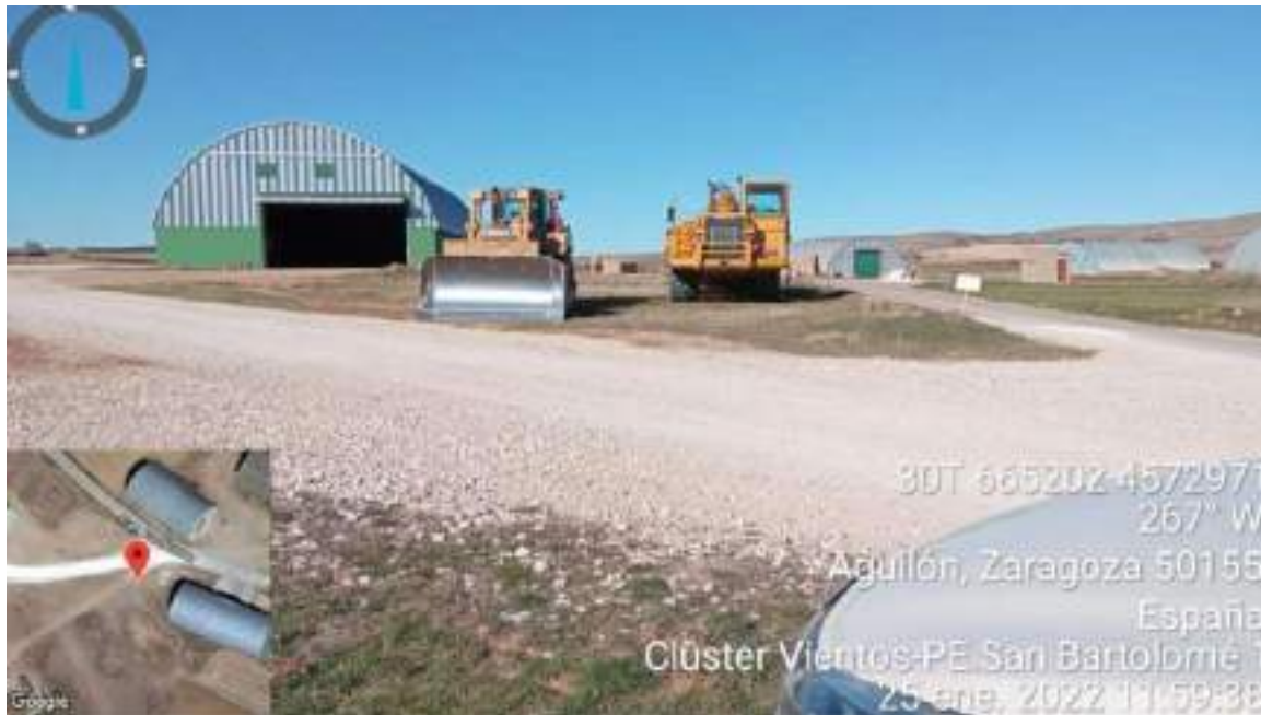
Imagen 1. Maquinaria sobre terreno
