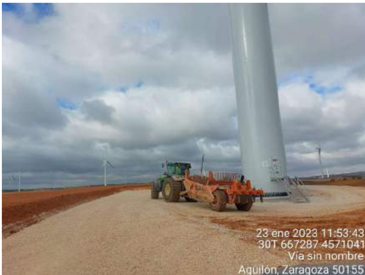
Imagen 2. Maquinaria realizando trabajos de restauración en PLX-02
