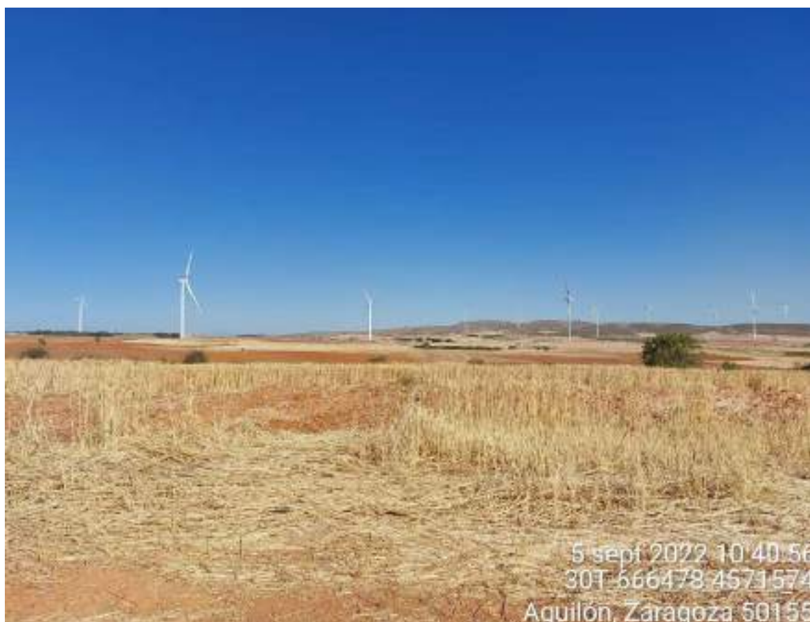
Imagen 1. Fotografía general del parque.
