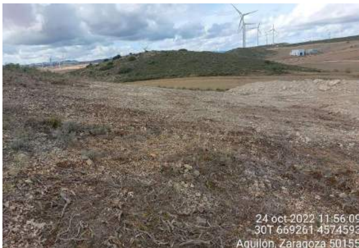
Imagen 1. No conformidad leve. Sobre afECCIÓN zona de vegetación natural en SBI-04.
