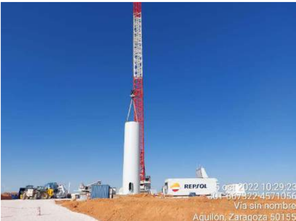
Imagen 4. Grúa colocando T1 en PLX-02.
