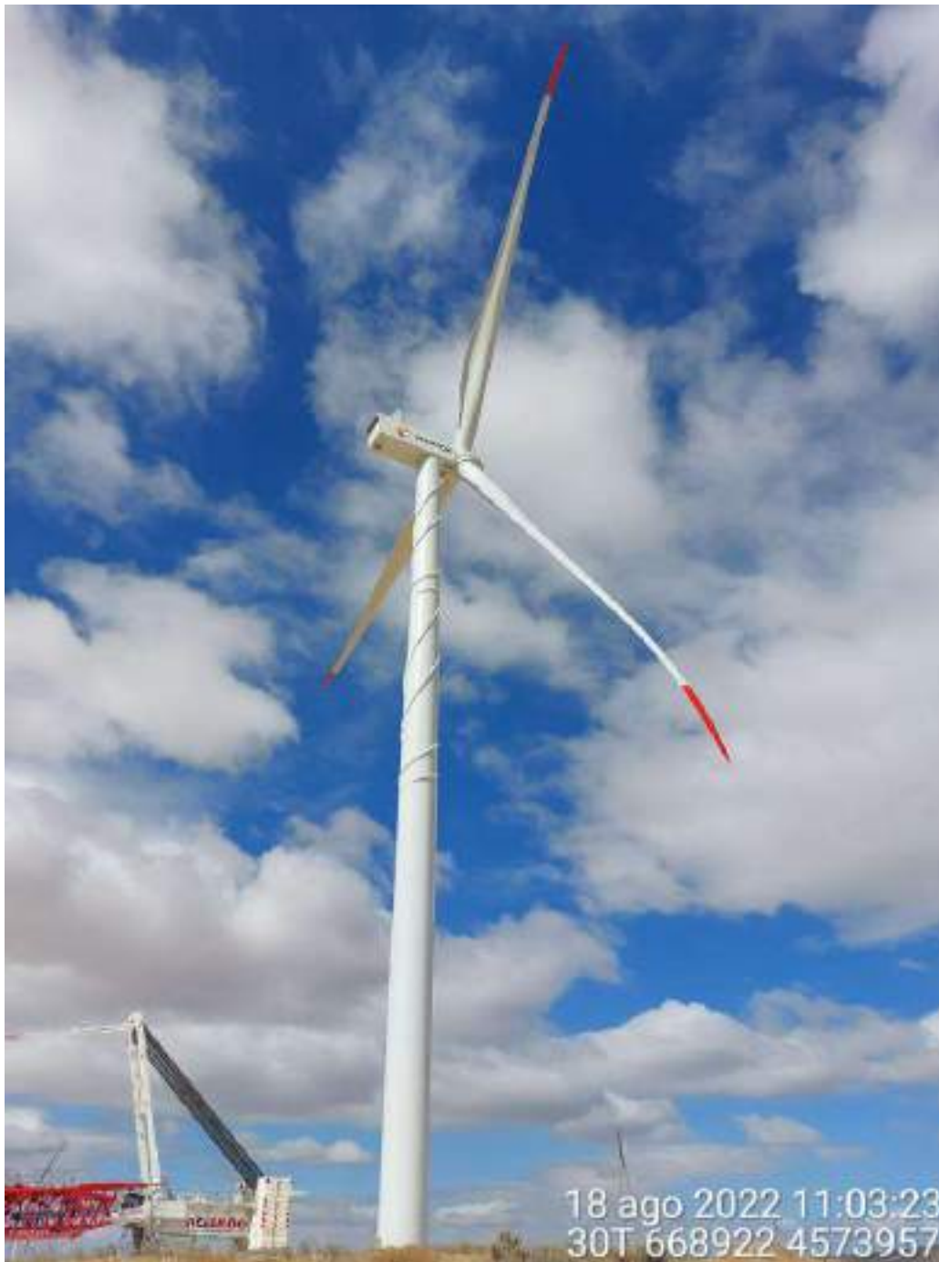
Imagen 2. Aerogenerador en fase de montaje.
