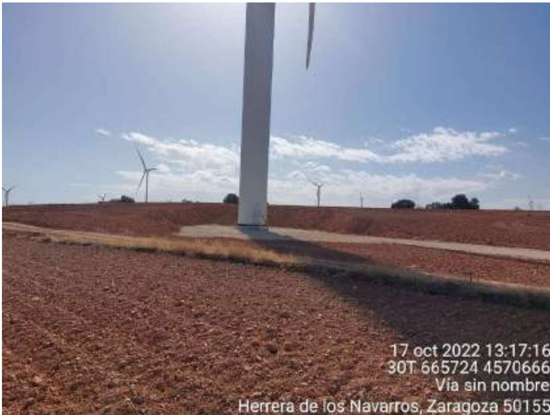
Imagen 2. Plataforma SBII-08 tras su restauración ambiental.
