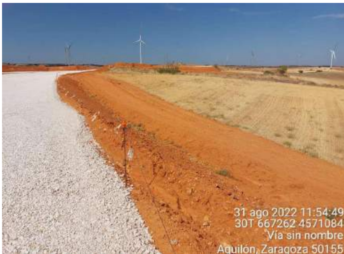
Imagen 1. Posición PLX-02 durante la visita de restauración.
