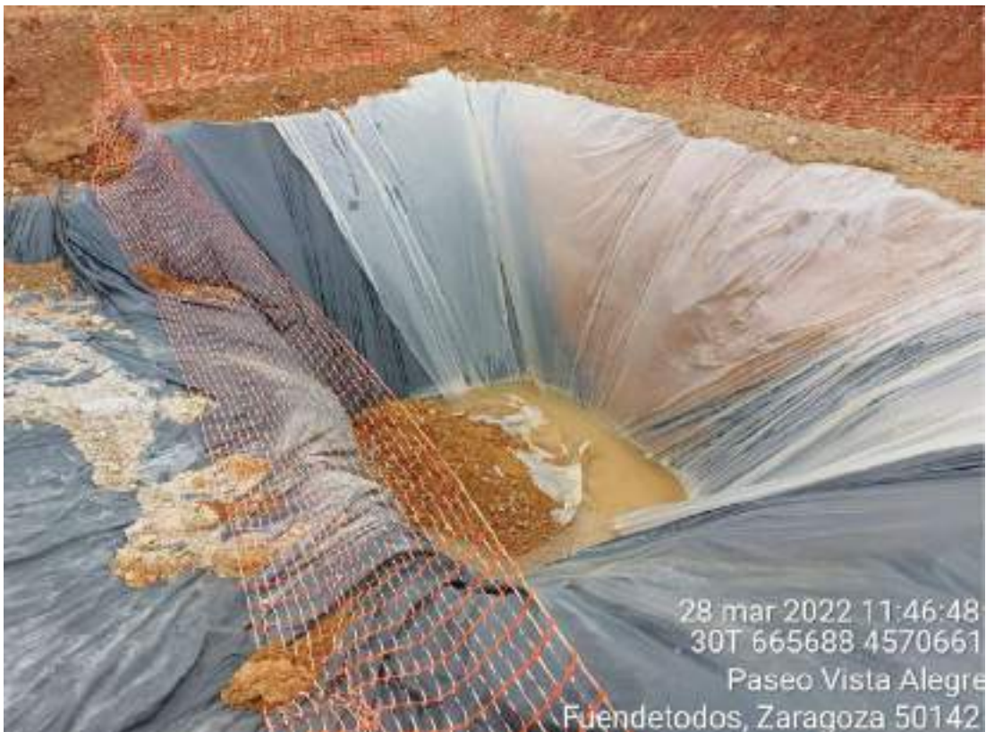
Imagen 5. Zona de lavado de SBI-8 en óptimo estado tras haberse utilizado.
