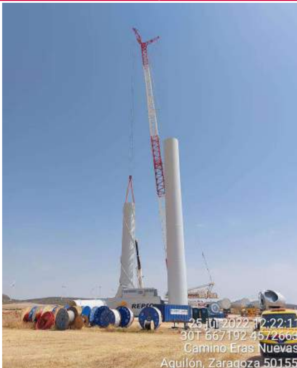
Imagen 2. Montaje del aerogenerador SB1-09
