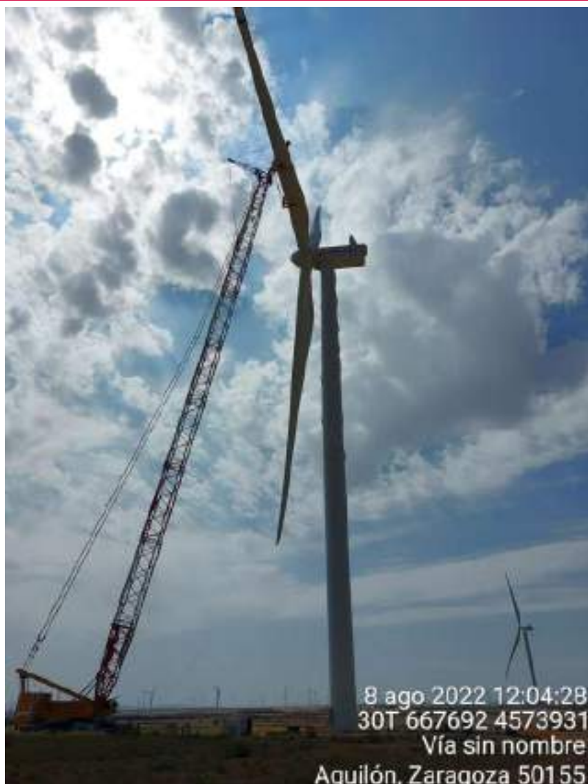
Imagen 3. Montaje aerogenerador.
