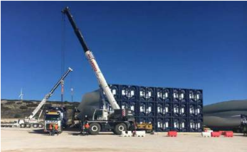
Imagen 5. Zona de acopio con palas
