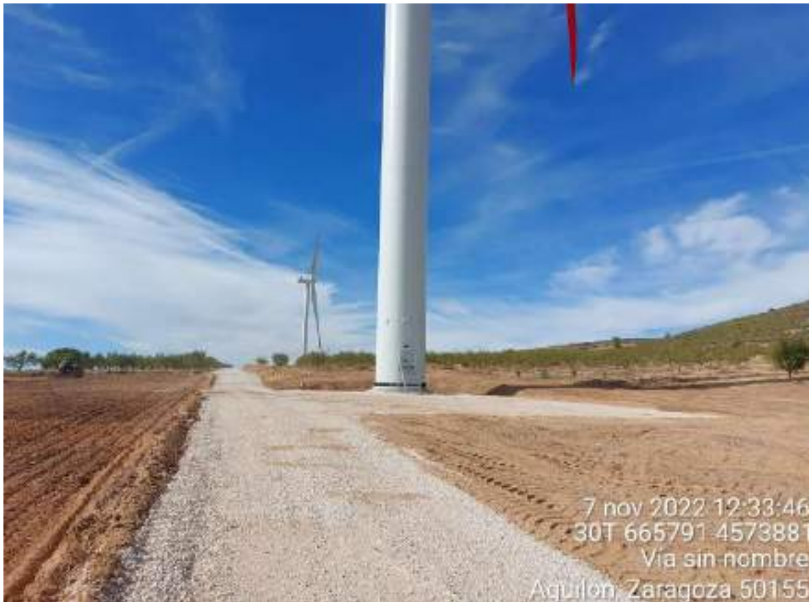
Imagen 4. Posición SBI-02 durante su restauración.
