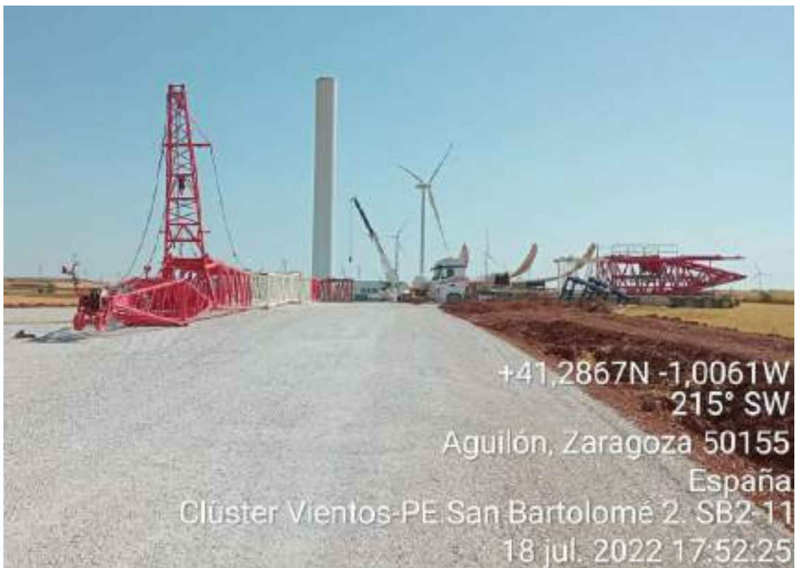
Imagen 2. Trabajos en plataforma de SB2-11
