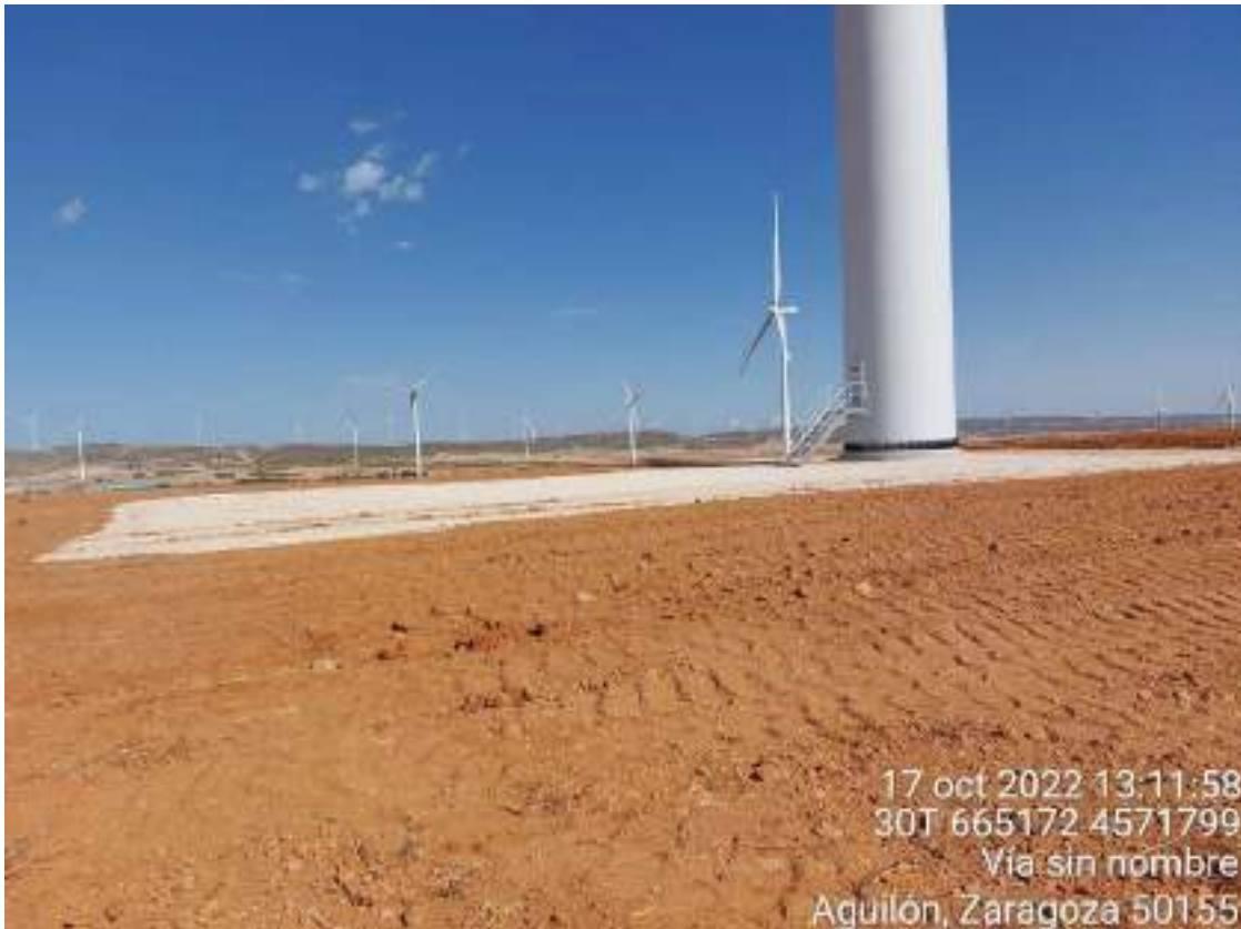
Imagen 1. Plataforma SBII-05 tras su restauración ambiental.
