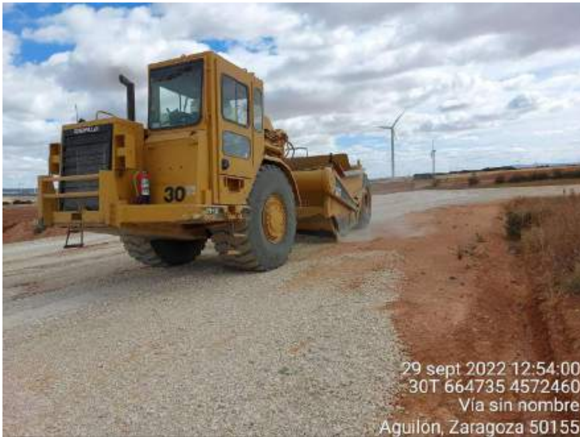
Imagen 2. Máquina quitando zahorra de la plataforma en el primer día de restauración ambiental de la obra en SBII-2.
