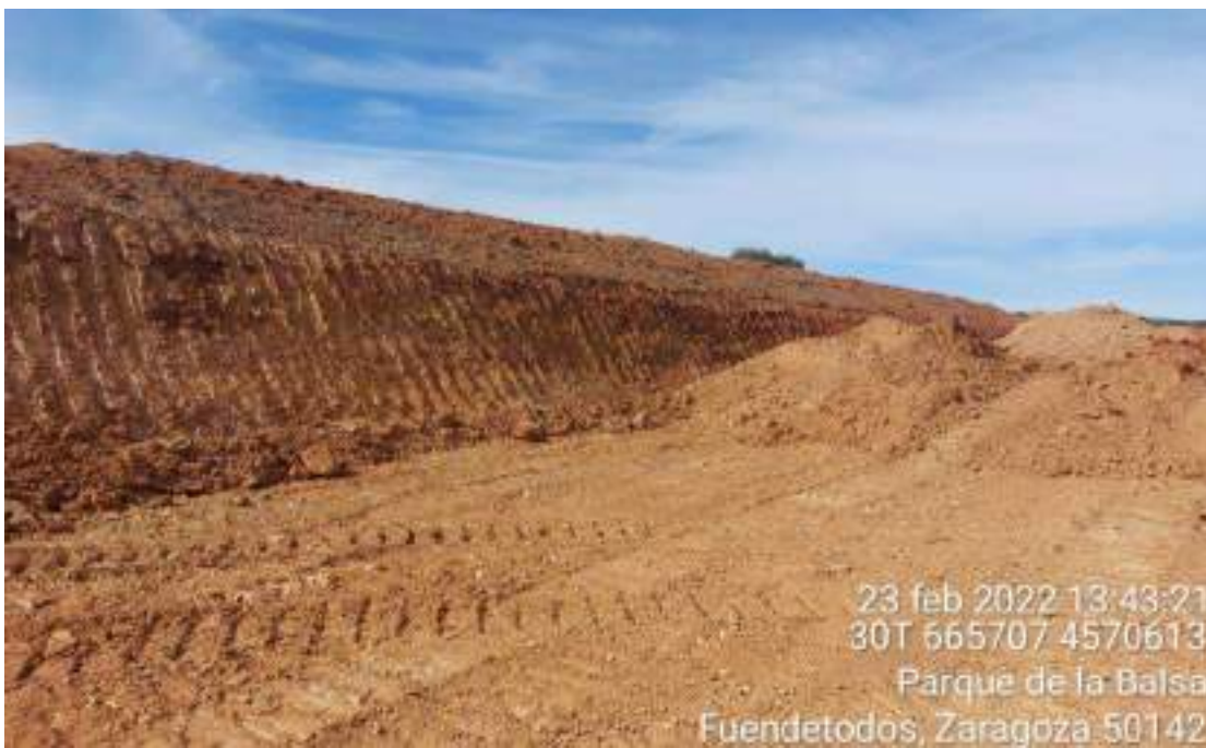
Imagen 4. Correcta separación entre tierra vegetal y resto de lo extraído en SBII-08
