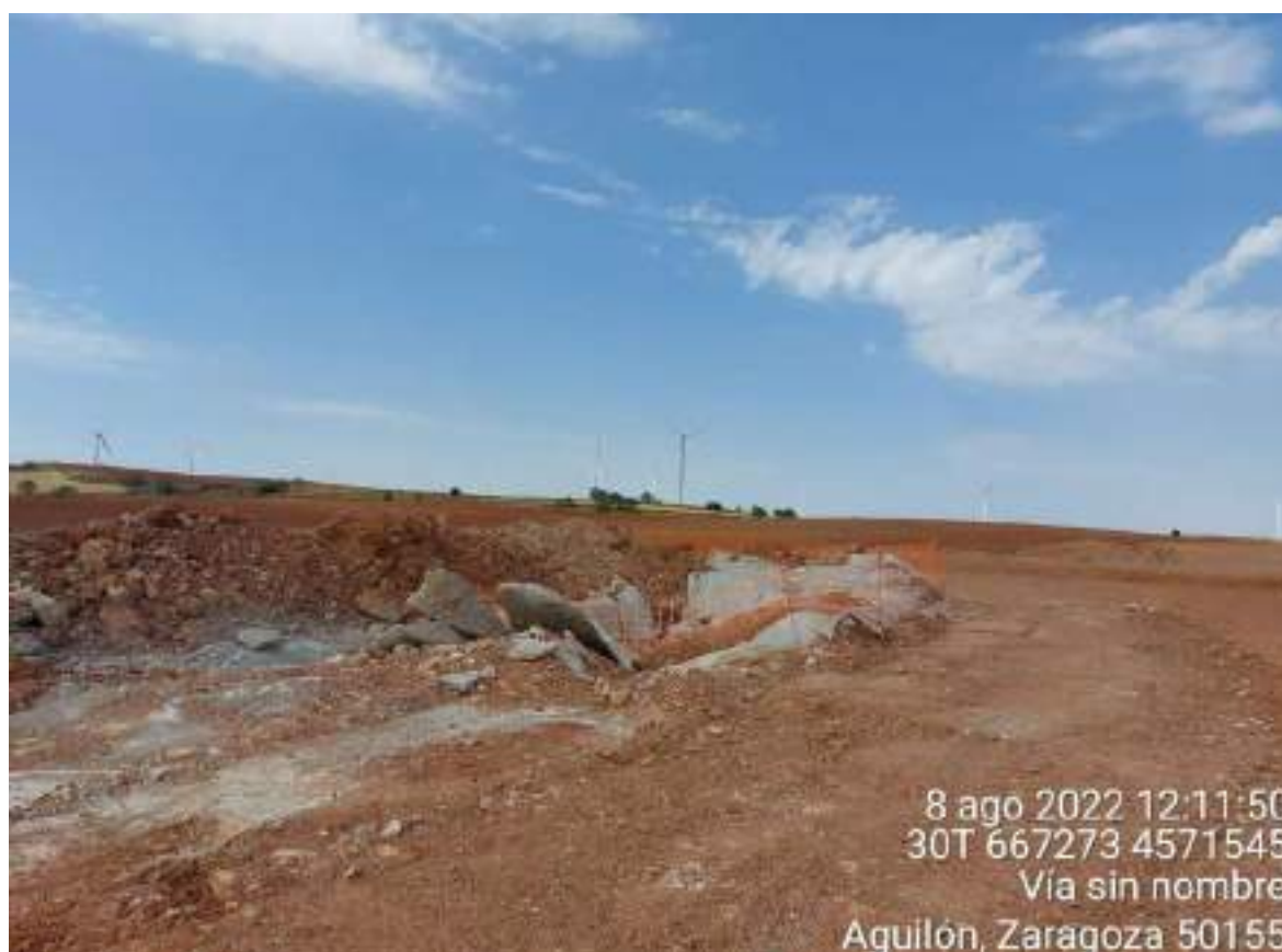
Imagen 1. Pozo de lavado sin restaurar.
